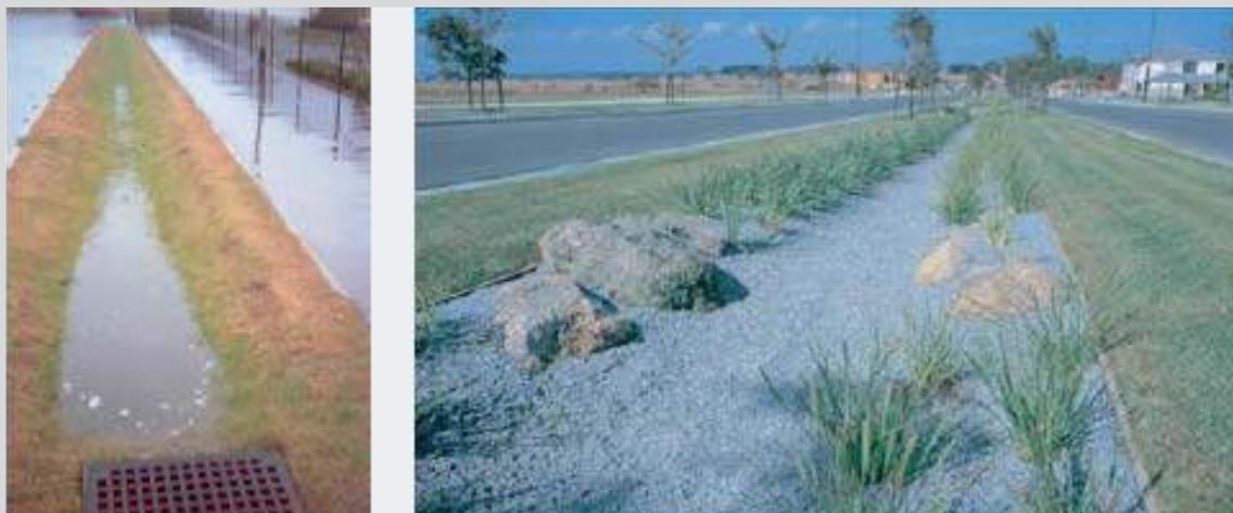
Figura 29 - Canali filtranti al margine delle strade possono essere estremamente efficaci nel ridurre i problemi ambientali dovuti alle piogge: la maggior parte delle acque di pioggia, infatti, proviene dal drenaggio delle strade.
