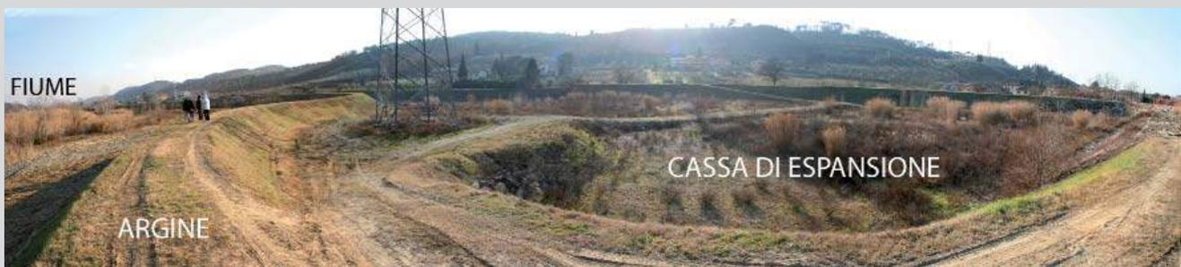
Figura 19 - Le casse di espansione solo in determinati casi sono costituite da grandi aree dall'elevato valore naturalistico e fruitivo; molto spesso sono aree altamente artificiali, racchiuse fra argini che le separano dal fiume e dal territorio (si veda ad esempio la cassa di espansione di Montelupo sul Torrente Pesa, in Toscana) (Foto: Bruno Boz).
