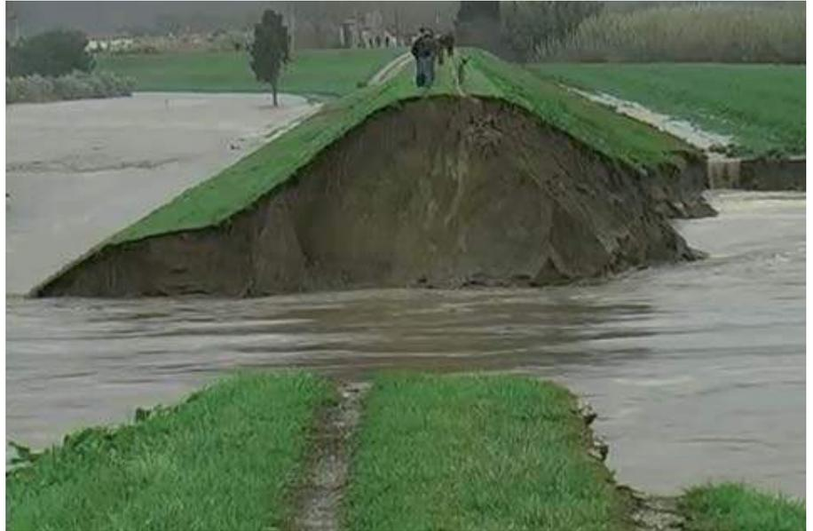
Figura 2 – Il caso della drammatica rottura dell'argine del fiume Serchio del Dicembre 2009 evidenzia la fragilità del sistema difensivo e conferma la necessità di una strategia che miri non solo a ridurre la pericolosità ma soprattutto a non incrementare i beni esposti.
