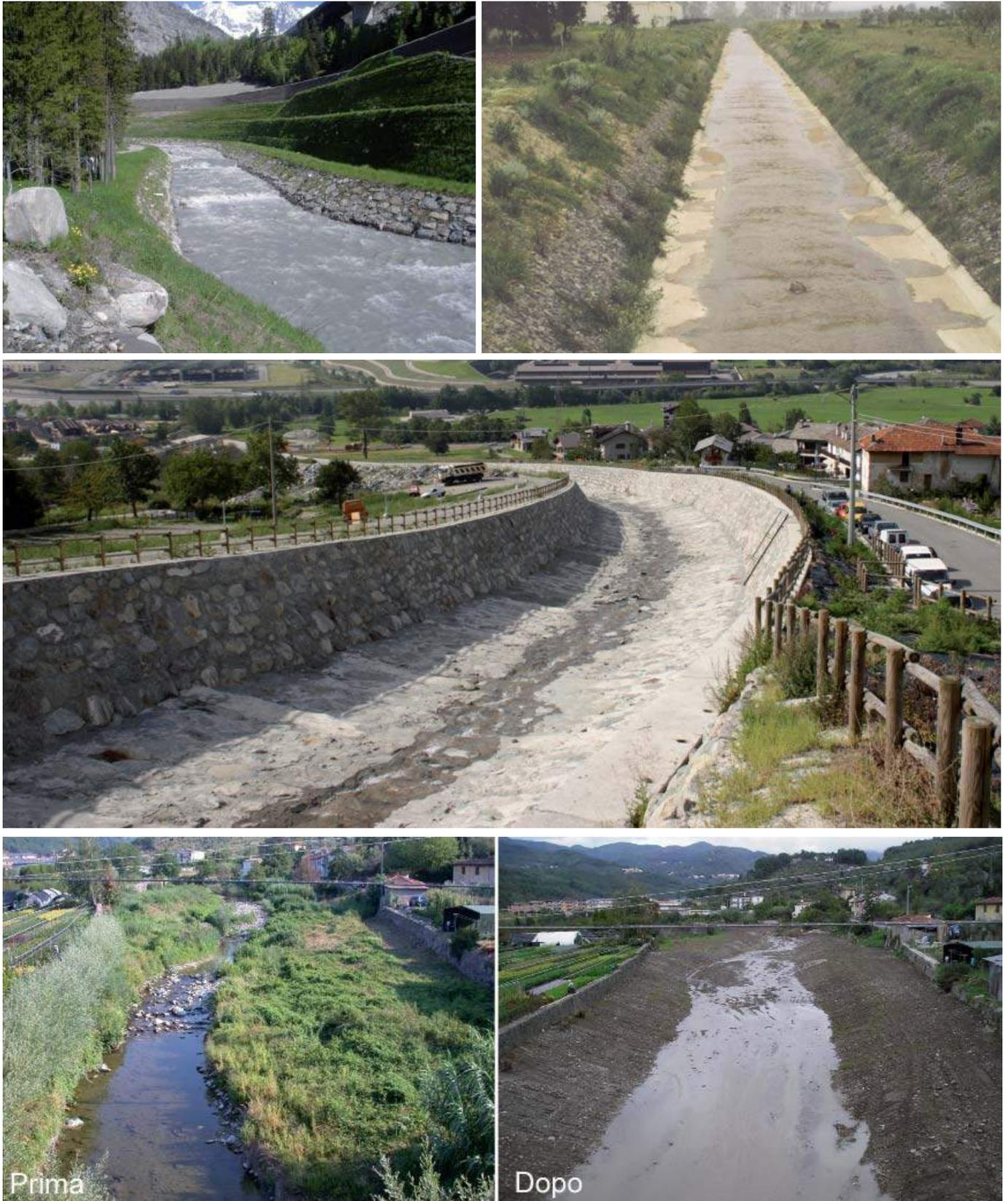
Figura 4 – Una panoramica di interventi idraulici “classici”, concepiti per “risolvere” problemi locali di rischio idraulico, che in realtà velocizzano i deflussi incrementando il rischio a valle (Foto: Bruno Boz).
