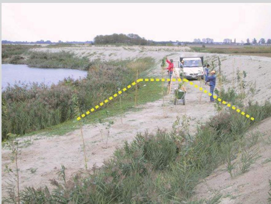
Figura 23 - Impianto di specie arboree lungo la nuova gola del Fiume Zero (VE) realizzata sbandando il vecchio argine (la cui sezione è indicata dal tratteggio) e ricostruendolo più esternamente. (Foto: Paolo Cornelio)
