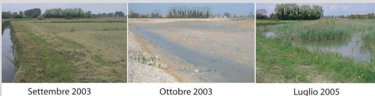
Figura 25. Eliminazione del rivestimento in calcestruzzo e creazione di una zona umida in alveo (Foto: Consorzio di Bonifica Dese Sile).
