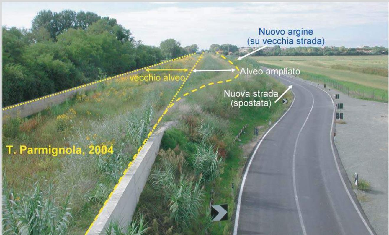
Figura 32 - Nell'immagine si osserva la leggera curva imposta al tracciato stradale per allontanarlo dall'alveo del torrente; le linee tratteggiate in giallo mostrano rispettivamente il vecchio alveo e il nuovo alveo ampliato. La freccia bianca a doppia punta indica l'ampliamento dell'alveo ottenuto: la nuova sezione permette il raggiungimento degli obiettivi idraulici (contenimento della piena con Tr 200) (Immagine: Giuseppe Sansoni).
