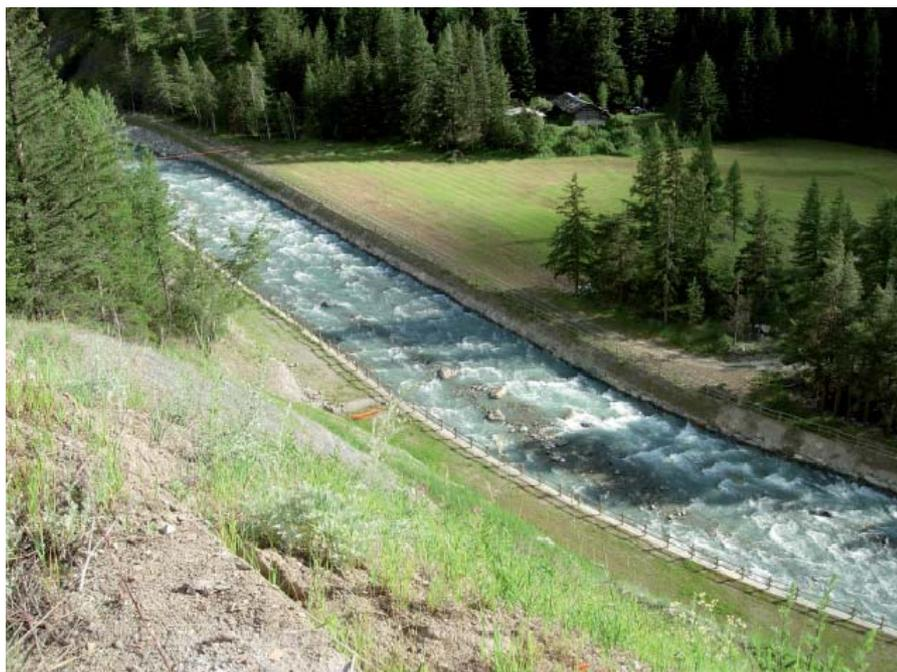
Figura 7 - Artificializzazione e conseguente velocizzazione del corso d'acqua. (Foto: Ileana Schipani)
