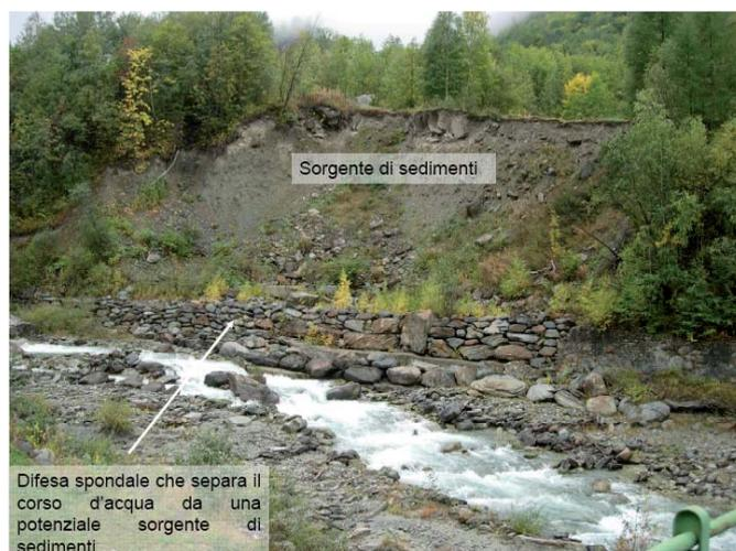
Figura 3 – Difesa spondale che impedisce l'attivarsi di fonti di sedimenti. (Foto: Ileana Schipani)
