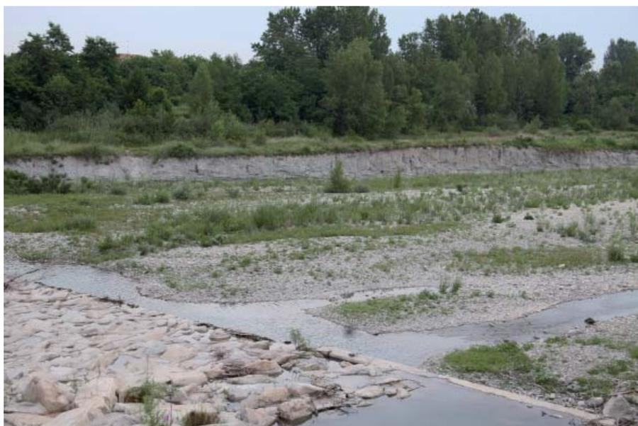
Figura 8 – Incisione (si noti la scarpata spondale sullo sfondo) a valle di un'opera trasversale (in primo piano). (Foto: Marco Monaci)
