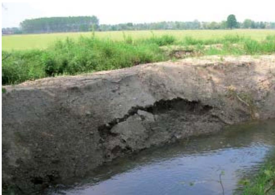
Figura 4 – La mancanza di vegetazione causa l'erosione della sponda. (Foto: Daniele Sogni)
