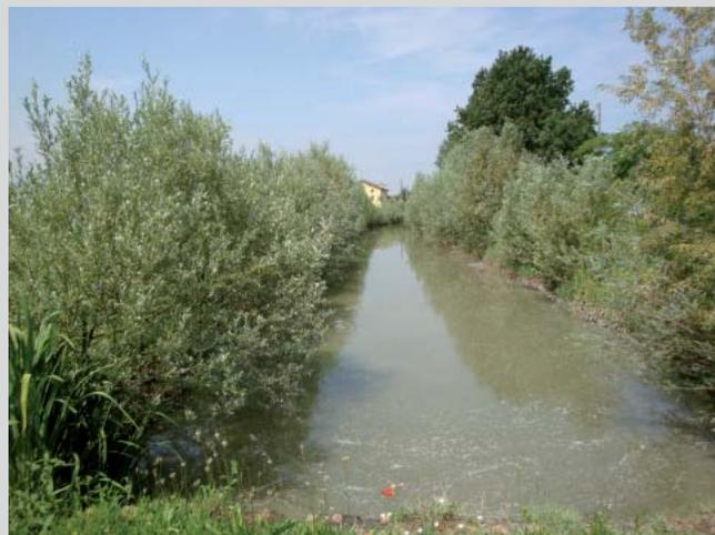
Figura 16 – Fascia riparia a salice bianco sviluppata in seguito alla realizzazione della palificata viva (a destra) e della palizzata viva (a sinistra) illustrate in Figura 15. (Canale di Budrione – Provincia di Modena – Consorzio di bonifica dell'Emilia Centrale) (Foto: Mario Fantesini)
