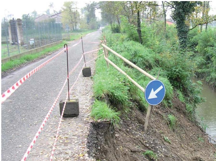
Figura 1 - Corso d'acqua in erosione in corrispondenza di un'opera viaria. (Foto: Marco Monaci)
