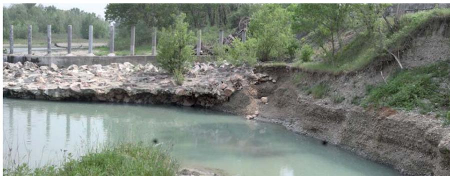
Figura 5 – Erosione di sponda (a destra nella foto) causata da una situazione di incisione localizzata a valle di uno sbarramento (a sinistra). (Foto: Marco Monaci)
