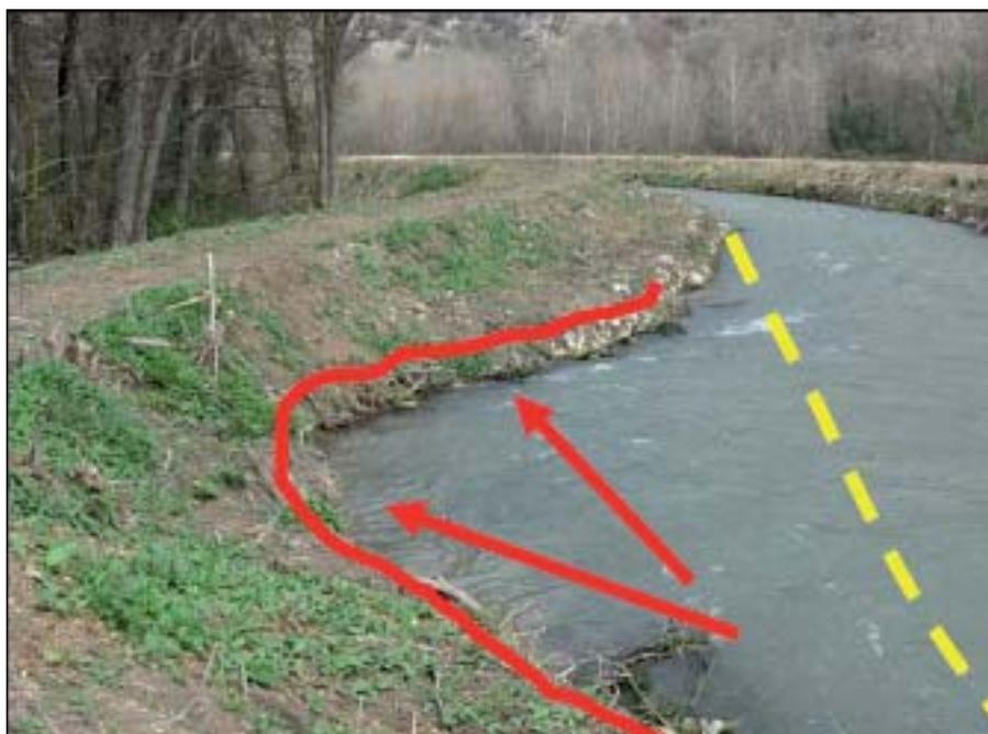
Figura 6 – Erosione spondale causata dall'aumento di velocità ed energia della corrente, conseguente all'artificializzazione (canalizzazione) dell'alveo. In giallo la sponda prima dell'erosione ed in rosso il nuovo profilo spondale (Foto: Ileana Schipani).
