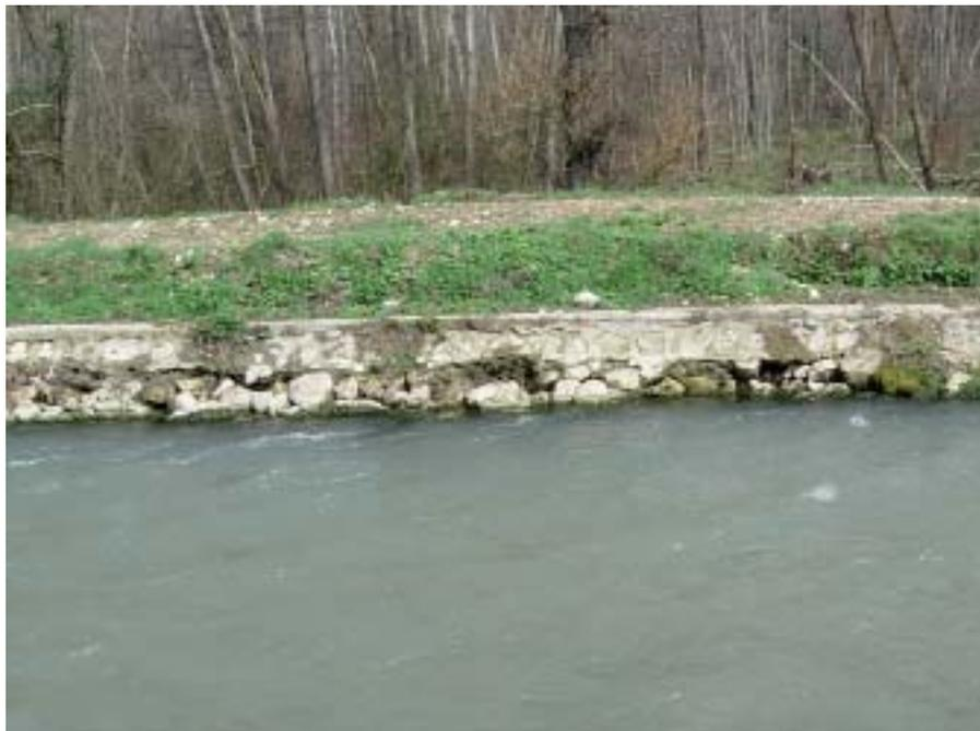
Figura 7 – Ammaloramento di difese spondali in seguito ad erosione del piede di sponda (Foto: Ileana Schipani).
