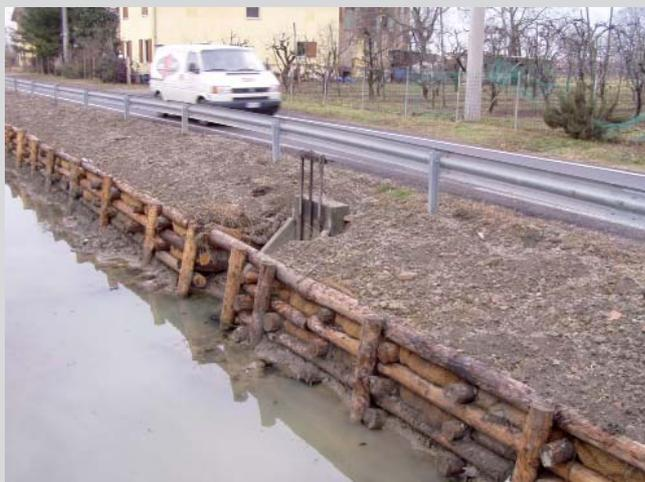
Figura 15 - Palificata viva realizzata lungo un canale artificiale onde evitare erosioni in corrispondenza di una strada. L'intervento è stato poi completato mediante messa a dimora di talee di salice, così da creare una fascia riparia seppur semplificata. Il risultato dell'intervento dopo 4 anni è visibile in Figura 16 (Canale di Budrione – Provincia di Modena – Consorzio di bonifica dell'Emilia Centrale). (Foto: Marco Monaci)
