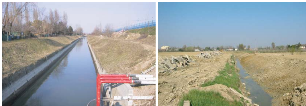
Fig. 13.10. Rivestimento in calcestruzzo (sinistra) e sua rimozione (destra). (Foto: Consorzio di Bonifica Dese Sile)
