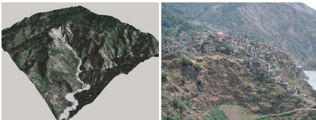
Fig. 18.3. A sinistra: il bacino della fiumara Amendolea. A destra: l'abitato di Roghudi, completamente abbandonato dagli anni '70 per l'instabilità della collina, minacciata dalle piene della fiumara (visibile a destra). (Fonte: a sinistra, Centro Cartografico Regione Calabria; a destra: F. Scionti)
