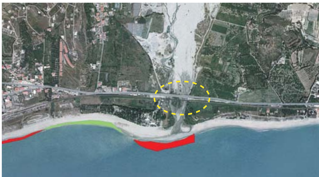
Fig. 18.12. Foto aerea della fiumara Amendolea nel tratto subito a monte della foce: è molto evidente il restringimento dell'alveo causato sia dagli argini che, nell'ovale giallo, dal ponte (le cui pile lato monte sono tra l'altro state travolte, durante un'alluvione, dall'onda d'urto del materiale solido trasportato dall'acqua). In rosso vengono indicate le aree costiere erose dagli anni '50 ad oggi (in verde un tratto accresciuti, nonostante globalmente il bilancio sedimentario sia deficitario. (Fonte: Autorità di Bacino della Calabria, elaborato PAI )
