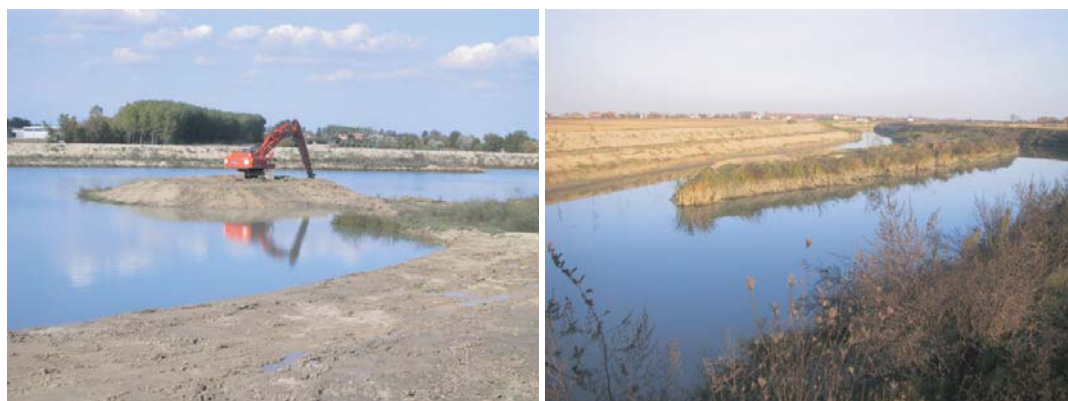
Fig. 13.9. Isola fluviale creata ex novo all'interno del fiume Zero (sinistra), o sfruttando il vecchio argine e scavando un secondo alveo, parallelo al primo (destra). (Foto: Consorzio di Bonifica Dese Sile)
