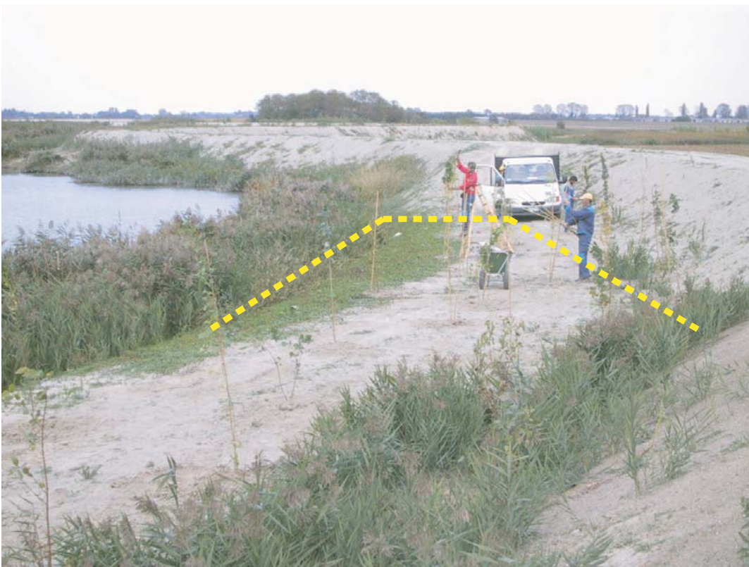
Fig. 13.8. Impianto di specie arboree lungo la nuova golena del Fiume Zero realizzata sbancando il vecchio argine (la cui sezione è indicata dal tratteggio) e ricostruendolo più esternamente. (Foto: P. Cornelio)
