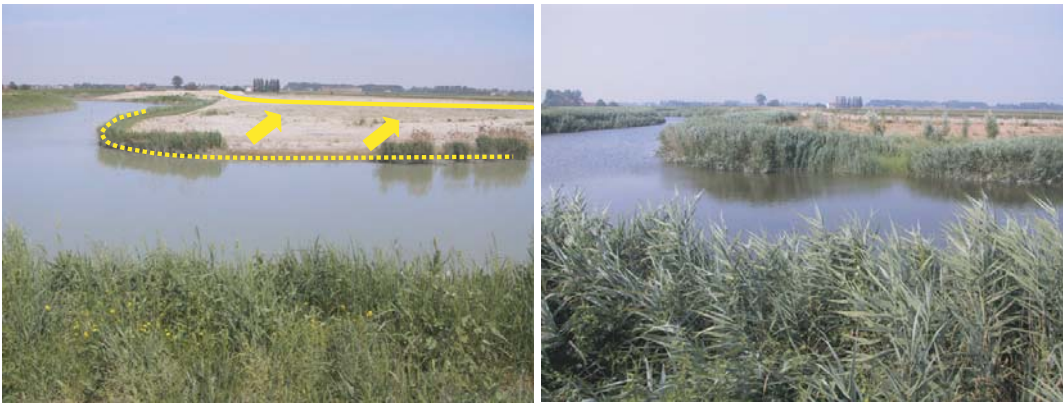
Fig. 13.7. Golena di meandro realizzata sul Fiume Zero: maggio 2003 (sinistra). Le frecce indicano l'arretramento del vecchio argine (linea tratteggiata) alla nuova posizione (linea continua). A destra, lo stato della vegetazione nel luglio 2004. (Foto: B. Baldo)
