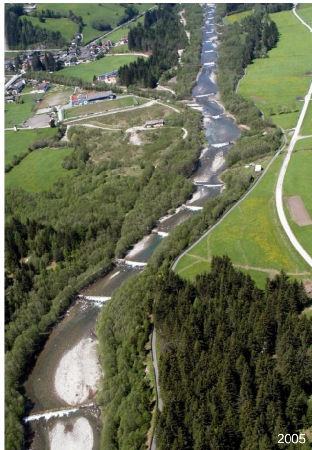
Prima dei lavori
