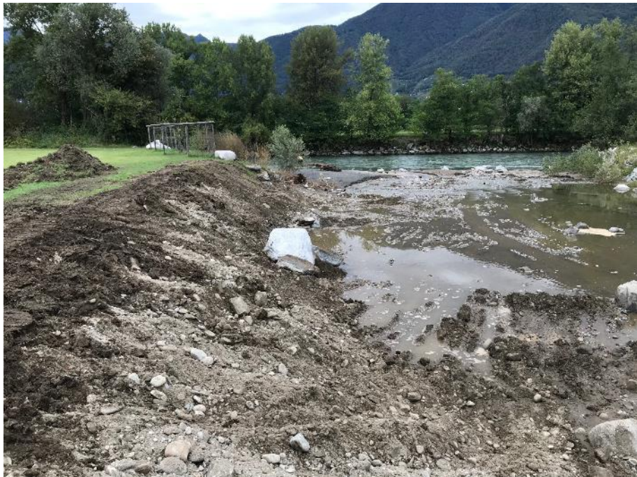
Fase di cantiere
