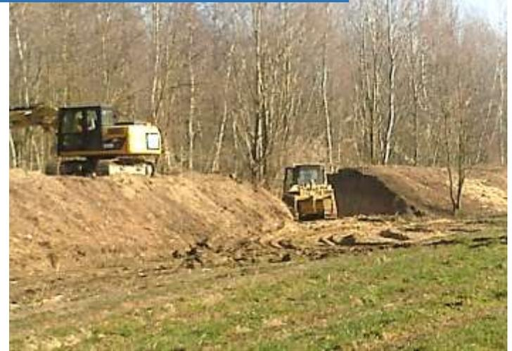
un grande intervento di rimozione delle arginature che consente una laminazione ampia laddove gli alvei raggiungono una ampiezza di oltre 440 metri. Sono stati demoliti **circa 3 km di rilevati arginali** in destra Montone e sinistra Rabbi. L'intervento è stato completato nel 2015.
