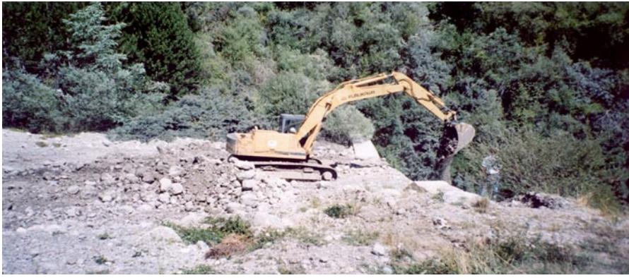
Figura 1 – Spostamento di sedimenti a valle di una briglia (Beoux river, Francia).
