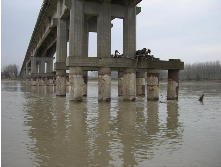
Figura 1 – Esempio di approfondimento delle quote di fondo dell'alveo nel fiume Po e conseguente scalfamento delle fondazioni dei ponti (Foto: Autorità di bacino del fiume Po)
