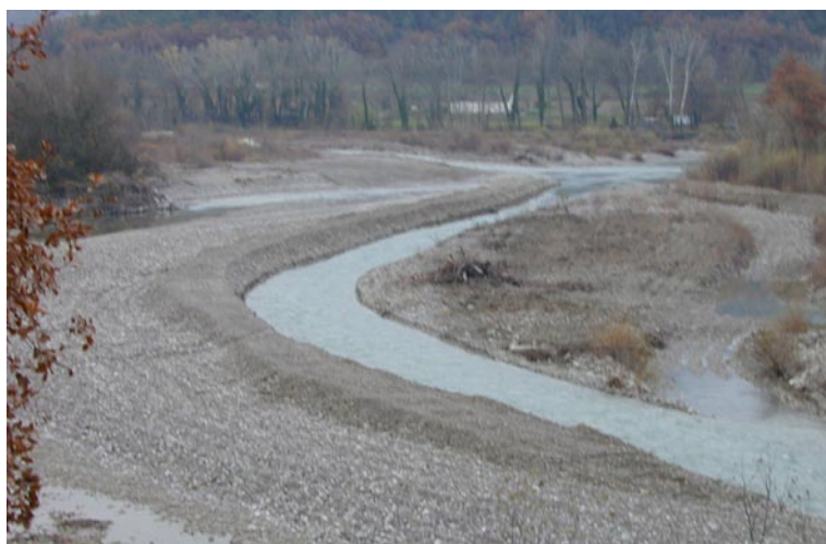
Figura 3 – Ricreazione di un ramo secondario nel progetto di riqualificazione del Fiume Rodano a valle della diga Pierre Benite (Lione, Francia).
