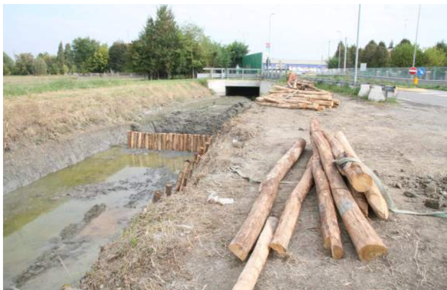
Figura 9 - Scavo della trappola per sedimenti. A sinistra nella foto si nota l'approfondimento del canale di circa 60 cm rispetto alla quota originaria del fondo alveo (si veda il livello dei fanghi presente poco più a valle); lo scavo è poi stato contornato da una fitta rete di pali di castagno infissi nel fondo, in modo da garantire il mantenimento della forma impostata per la trappola. (Foto: Marco Monaci).
