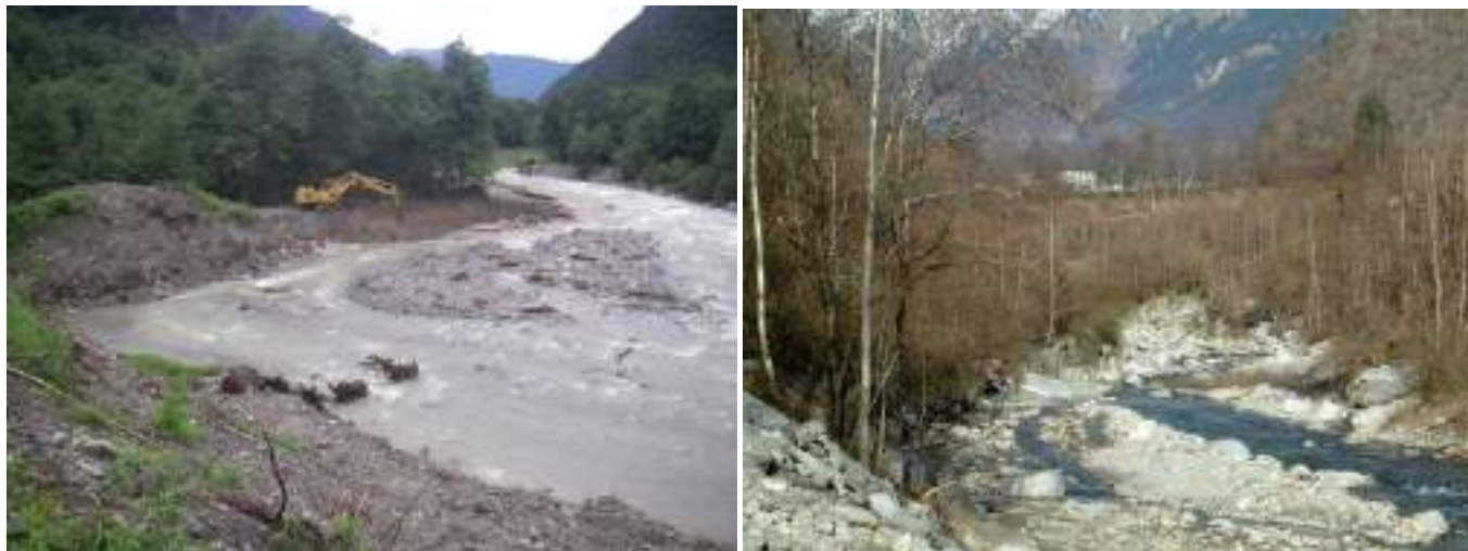
Figura 4 - Lavori in corso nell'alveo del Moesa nell'area di Fordecia; gli interventi di rimozione delle difese spondali e ampliamento dell'alveo potrebbero diventare una prassi diffusa nei corsi d'acqua della Svizzera (fonte: Gewässeraufwertungsmassnahmen im Kanton Graubünden).
