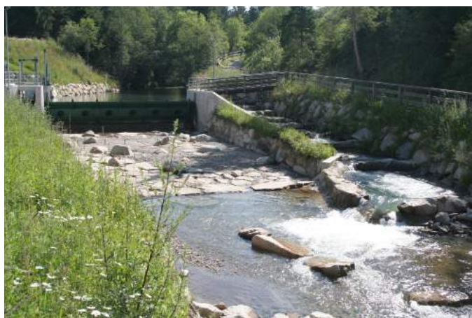
Figura 4 – Un'opera di presa di un impianto ad acqua fluente dotata di un passaggio per pesci (visibile sulla sinistra); la realizzazione di passaggi per pesci risulta essere uno dei più comuni interventi di mitigazione dell'impatto sulle comunità ittiche.
