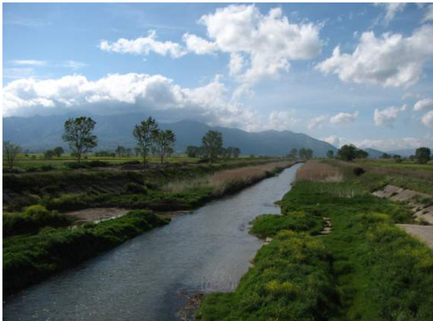
Figura 6 – Il Fiume Tanagro nel tratto canalizzato e rettificato. È evidente la sezione trapezoidale con le sponde (e, in alcune zone, anche il fondo) in cemento. (Foto: Mauro Lafratta).
