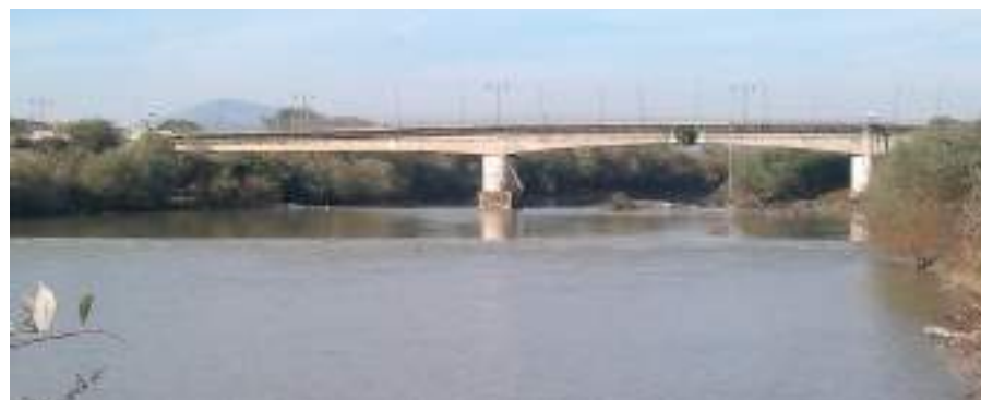
Figura 4 - Foto del ponte Garibaldi da valle (2011).
