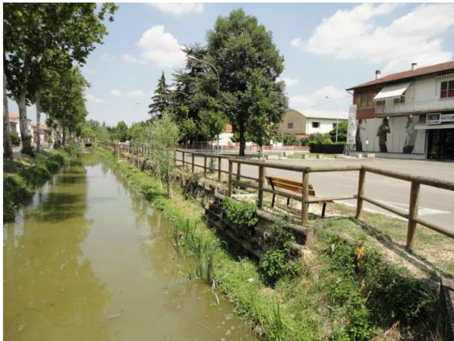
Figura 8 - Lungo il canale sono state predisposte alcune aree di sosta ricavate nella banca presente in destra idraulica, nelle porzioni non abbassate per creare la golena allagabile. Il filare alberato messo a dimora lungo la sponda permetterà progressivamente di fruire il canale in una situazione maggiormente ombreggiata e accogliente (Foto: Marco Monaci).
