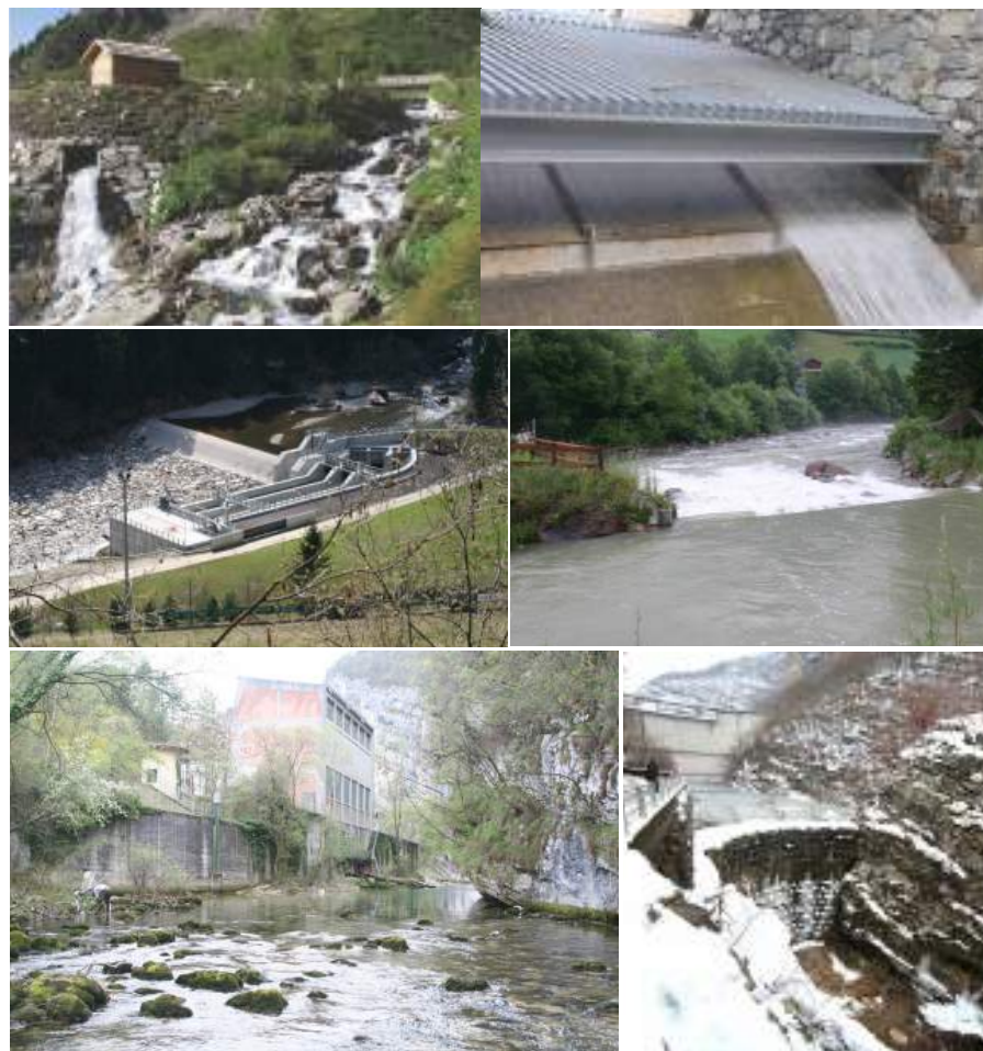
Figura 6 – Alcuni esempi di impianti in cui è stata testata la metodologia di certificazione CH 2 OICE. Dall'alto: un piccolo impianto ad acqua fluente di alta quota con elevate pendenze, di cui si osserva una panoramica dell'opera di presa ed un dettaglio della stessa con il rilascio del DMV; un impianto di dimensioni più elevate, sempre ad acqua fluente, con vista dell'opera di presa e dei dissabbiatori e del rilascio; un impianto con bacino di accumulo, di cui si osserva la centrale di produzione e la diga.
