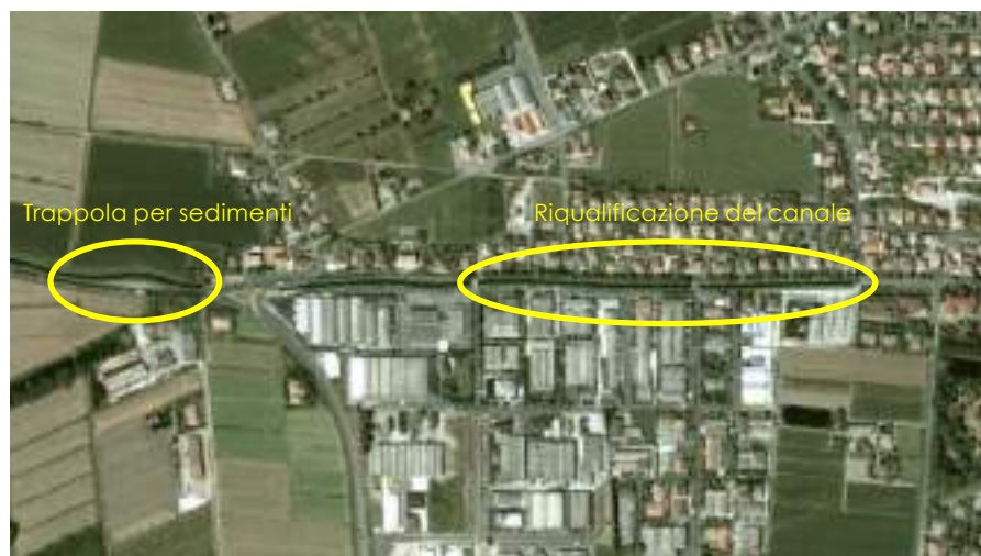
Figura 4 - Tratti di intervento sul canale a San Matteo della Decima, a monte del centro abitato (trappola per sedimenti) e all'interno dell'area urbana (interventi di riqualficazione del canale).
