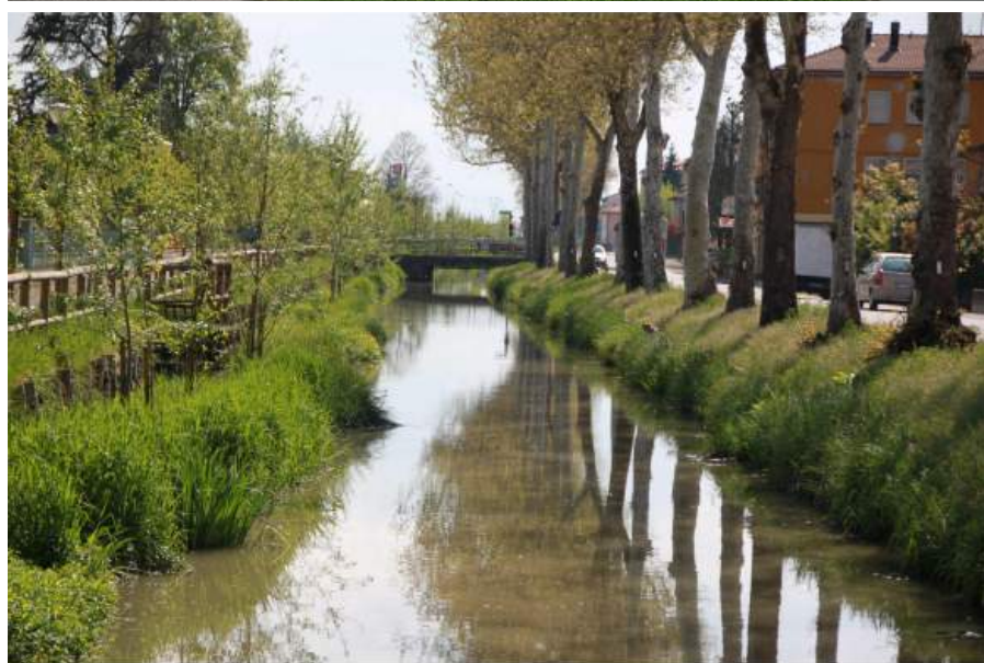
Figura 7 Il canale visto da valle verso monte, prima dei lavori (foto in alto) e dopo la realizzazione dell'intervento di riqualficazione fluviale (foto in basso). L'intervento è analogo a quanto descritto in Figura 6 (creazione di una golenale allagabile); si noti nella foto in basso la presenza delle elofite messe a dimora durante il progetto. (Foto: Marco Monaci -in alto- e Franco Govoni -in basso).
