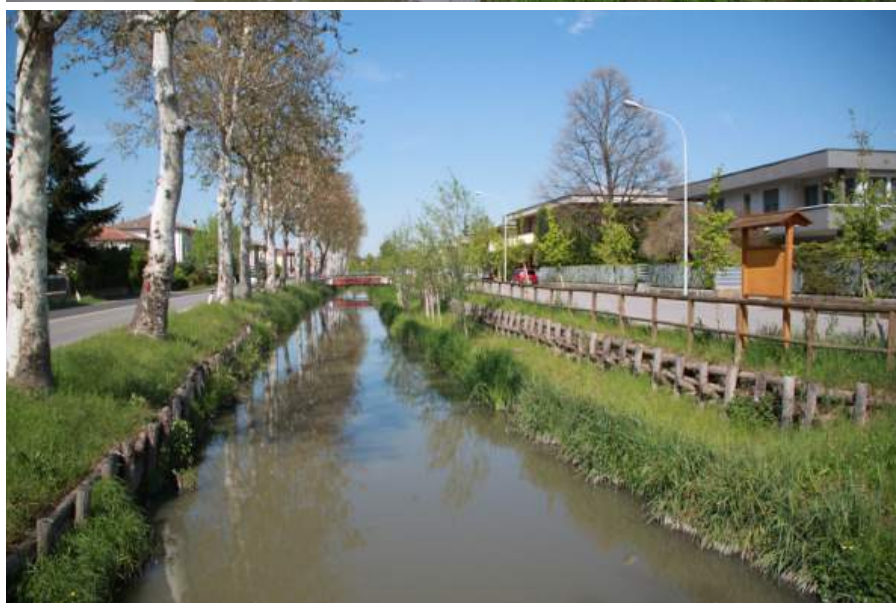
Figura 6 - Il canale visto da monte verso valle, prima dei lavori (foto in alto) e dopo la realizzazione dell'intervento di riqualficazione fluviale (foto in basso). La banca in destra idraulica è stata abbassata in modo da creare una piccola golena allagabile, colonizzata in seguito dalla vegetazione e ulteriormente forestata mediante messa a dimora di piante sparse sia arboree che arbustive (sullo sfondo nella foto). La sponda in destra è sorretta da una palificata e bordata da un parapetto in legno che permette una fruizione sicura del canale ora con sponde pseudo-verticali. (Foto: Marco Monaci -in alto- e Franco Govoni -in basso).
