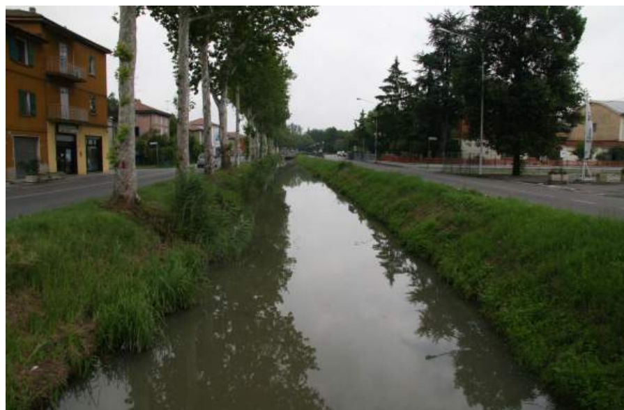
Figura 5 - Il canale visto da monte verso valle. Si noti a destra la stretta banca inerbita che separa il canale dalla strada a servizio dell'area industriale e a sinistra la strada statale posta subito a ridosso della sponda del canale, bordata da un filare di platani (Foto: Marco Monaci).
