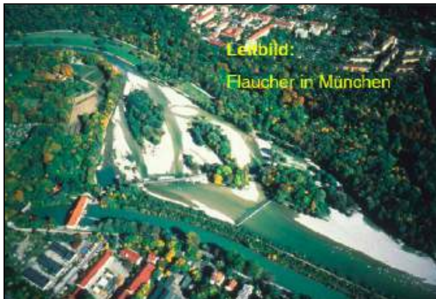
Figura 4 - Il tratto di Isar denominato "Flaucher", che rappresenta lo stato di riferimento per il progetto di riqualificazione (© Wasserwirtschaftsamt München).
