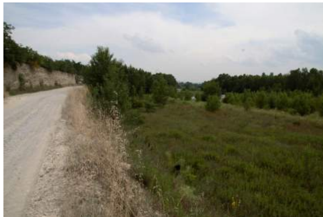
Figura 12 – I muri in calcestruzzo (a sinistra nella foto) che contornano il Panaro a valle di Spilamberto, costruiti negli anni '30 del '900 per evitare le piene nel territorio circostante, si trovano ora sospesi a quote ben superiori al fondo del fiume (a destra nella foto) a causa della sua incisione (Foto: Marco Monaci).
