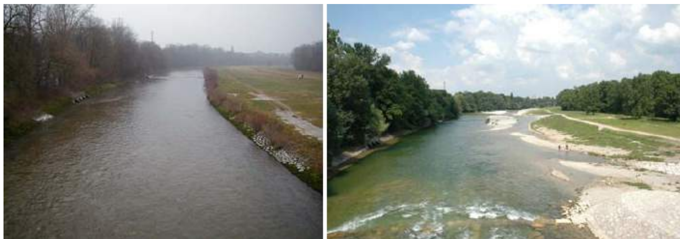
Figure 9 e 10 - Morfologia del fiume Isar nell'area urbana: a sinistra prima dell'intervento ed a destra dopo l'intervento di riqualificazione (© Wasserwirtschaftsamt München).
