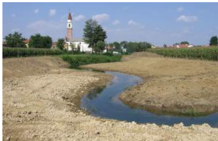
Figura 8 - Rio San Martino: nella ricalibratura dell'alveo si è dato un andamento sinuoso al canale di corrente e sono state realizzate delle banchine di espansione a pendenza variabile.
