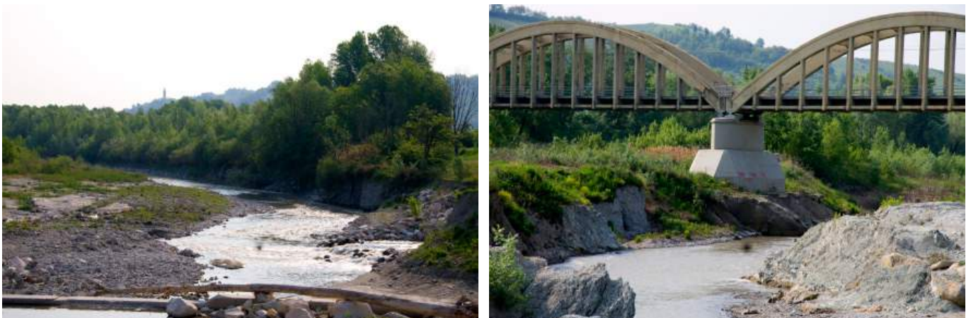
Figura 10 – Incisione dell'alveo a valle della traversa del ponte stradale di Vignola (foto a sinistra) e del ponte ferroviario Vignola-Bologna (foto a destra) (Foto: Marco Monaci).
