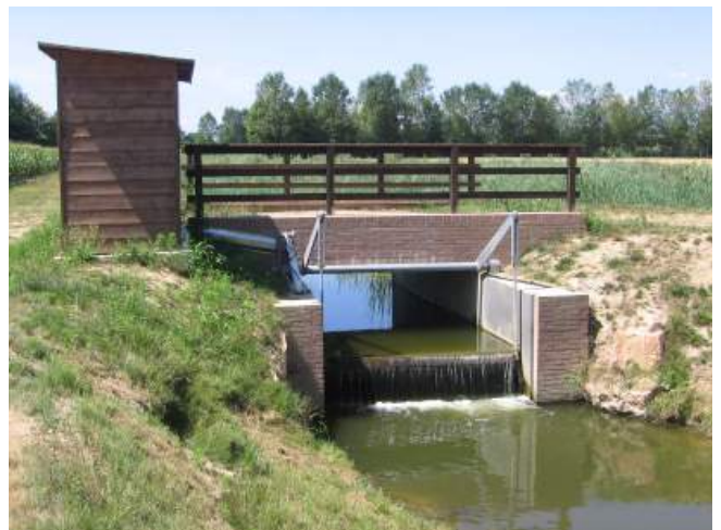
Figura 5 - Lungo gli affluenti del fiume Dese sono stati realizzati 7 manufatti di sostegno che vengono utilizzati nei periodi critici per mantenere sommerse le aree umide.
