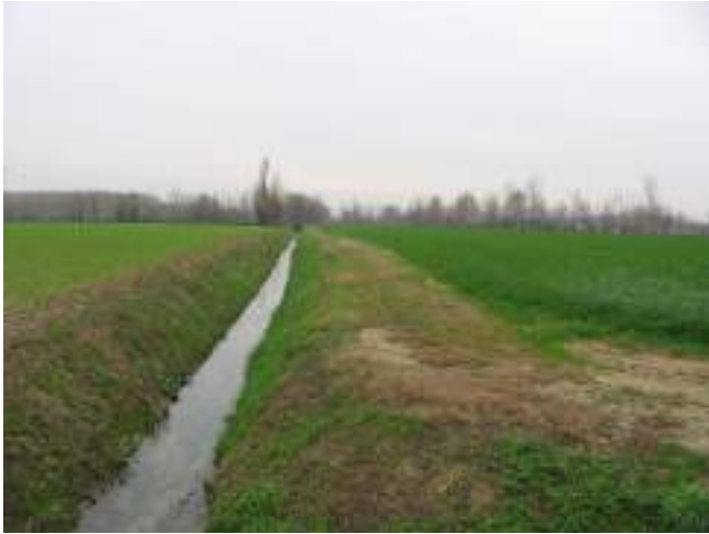
Figura 2 - Lo Scolo Desolino prima degli interventi di riqualificazione ambientale: la sezione del collettore si presentava di dimensioni ridotte, di forma trapezia e priva di vegetazione arborea e arbustiva.
