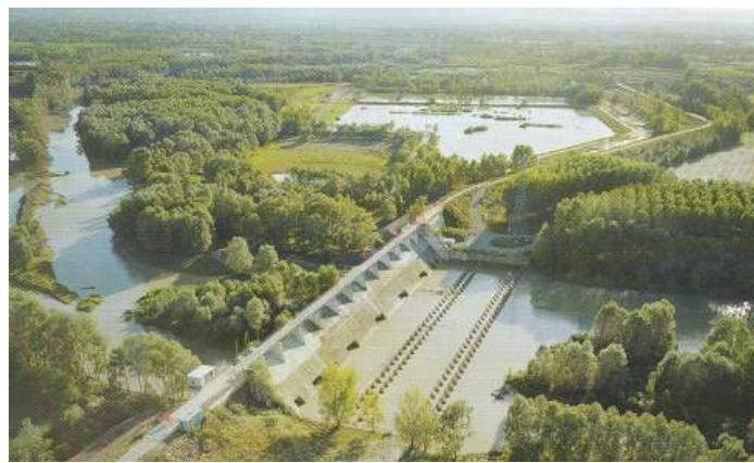
Figura 14 – Le casse di espansione del Fiume Panaro: il corso d'acqua (a sinistra nella foto) scorre all'interno delle casse, fino ad incontrare il manufatto regolatore (al centro nella foto), il quale permette il riempimento progressivo delle aree di ex cava (a destra nella foto), contornate dal sistema arginale che le separa dal resto del territorio (Foto: Archivio della Provincia di Modena).
