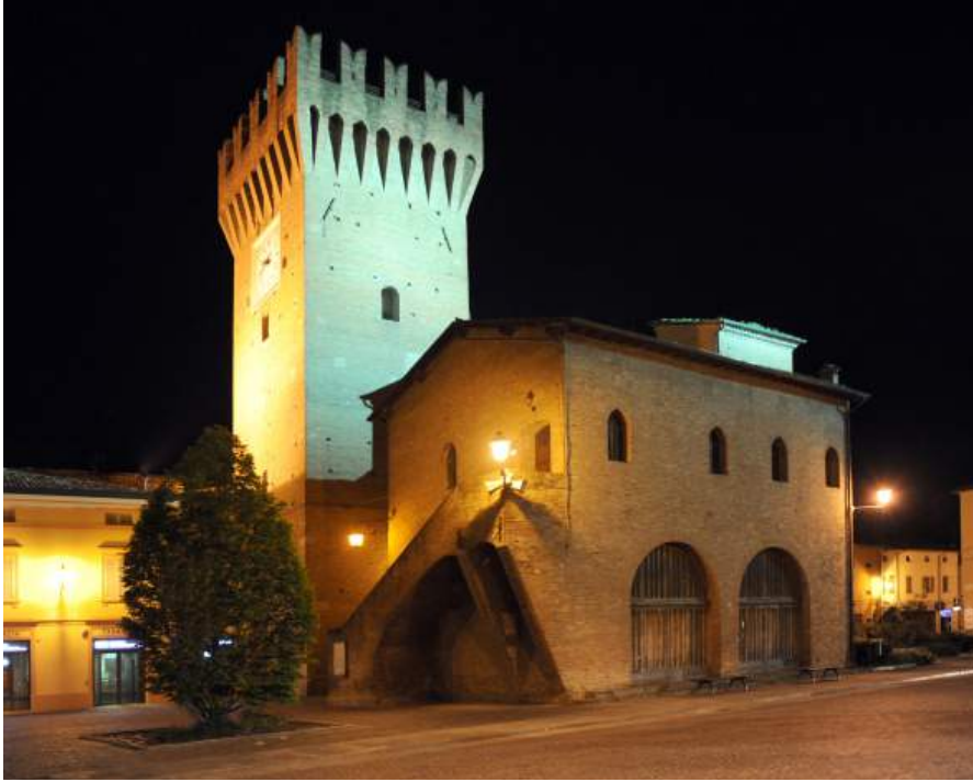
Figura 9 – Il "Torrione" di Spilamberto, complesso medievale posto all'ingresso principale del centro del paese, costruito a ridosso delle mura di cinta nel sec. XIV dal Comune di Modena (Foto tratta da: www.comune.spilamberto.mo.it ).
