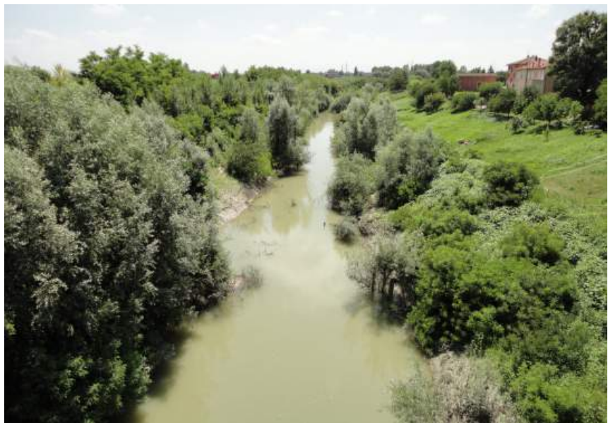
Figura 15 – Il tratto arginato del fiume Panaro nei pressi di Modena (Foto: Marco Monaci).
