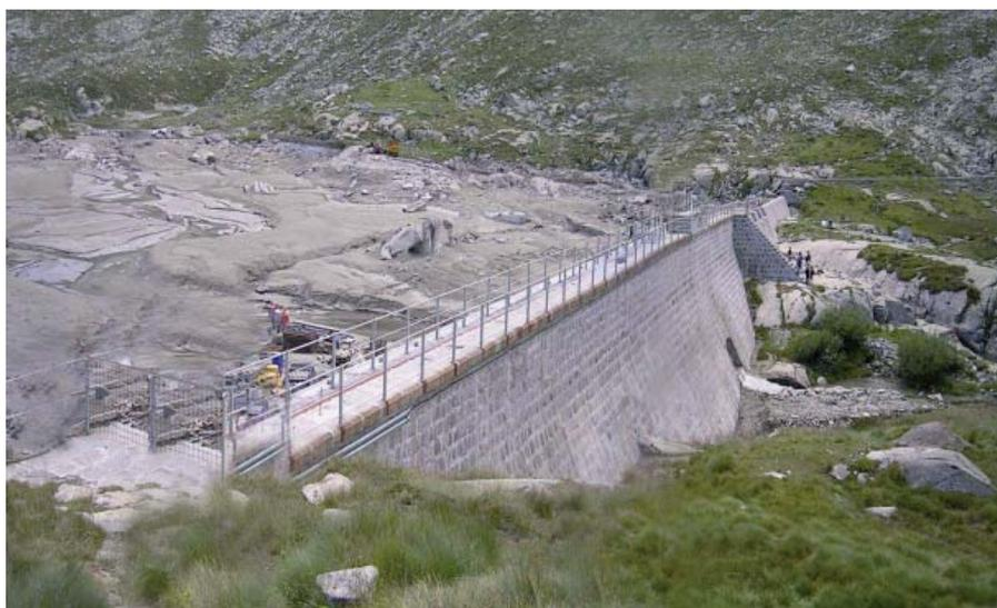
Figura 8 – L'ingente accumulo di sedimenti a monte della diga illustra efficacemente la riduzione di pendenza, la sedimentazione e l'innalzamento della quota del fondo indotte da ogni sbarramento. (Foto: Andrea Goltara)
