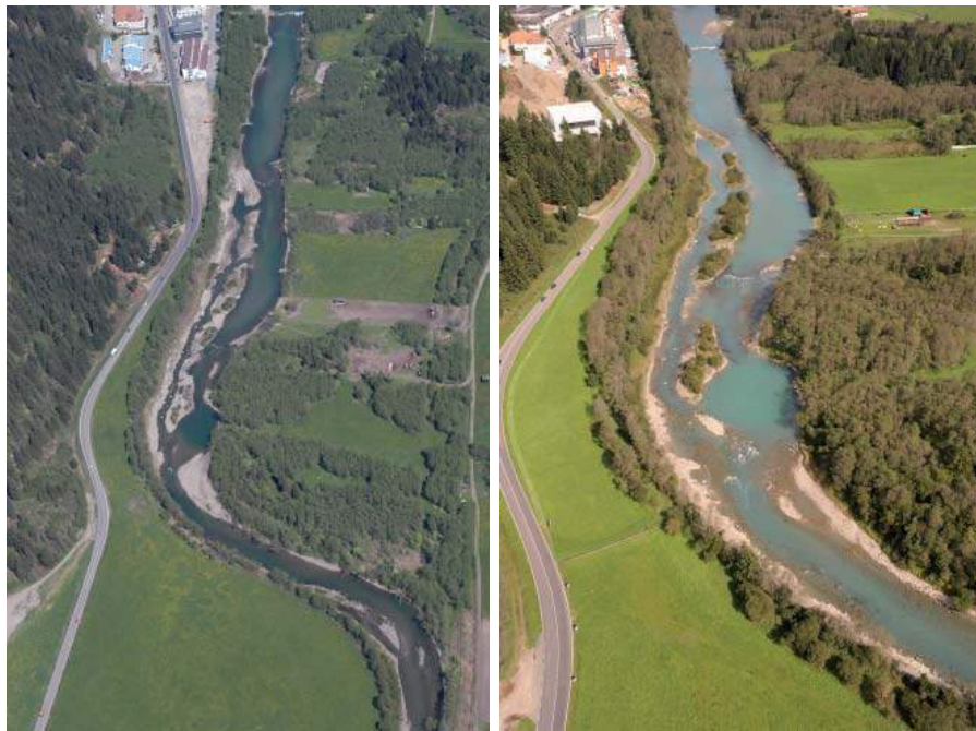
Figura 3 - Allargamento di Molini di Tures subito dopo la conclusione dei lavori (sinistra) e nel 2008 (a destra).
