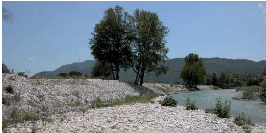
Figura 12 - Argine fluviale dopo la realizzazione (si veda la Figura 6 per confronto): la vegetazione riparia esistente è stata rimossa quasi completamente.
