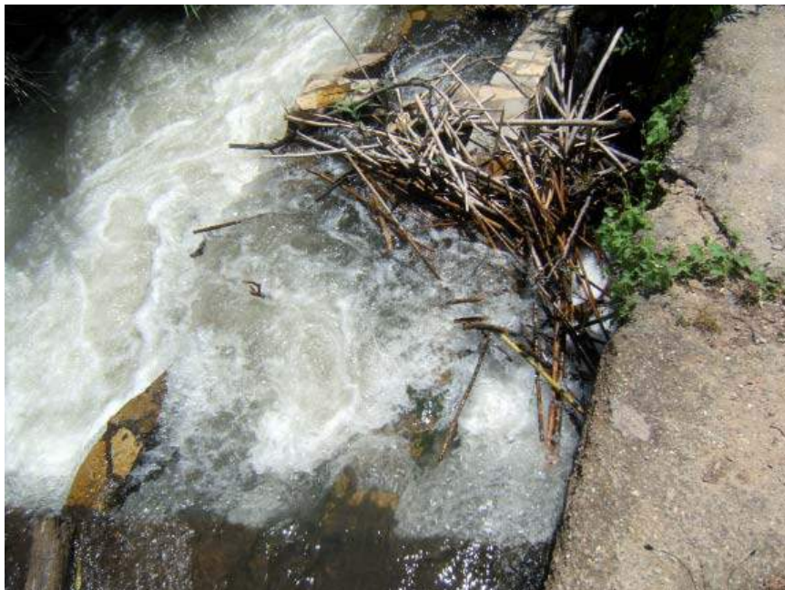
Figura 8 - Rampa in pietra dello sbarramento di Guado della spina, dopo tre mesi dalla realizzazione. Figura 9 - Passaggio tecnico di San Savino 1 intasato dai detriti.
