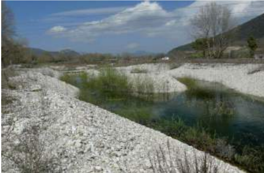
Figura 9 - Desolante vista dell'interno dell'area realizzata. Solo qualche talea (immersa in acqua) ha attecchito. Da notare la composizione molto grossolana delle pareti e la totale assenza di terreno vegetale.
