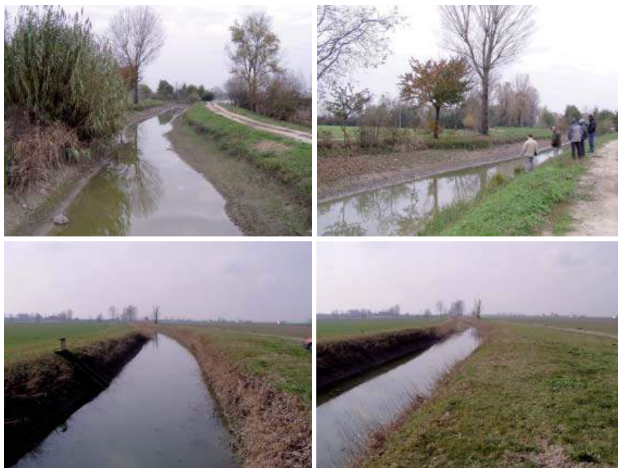
Figura 8 – Cavo Migliarina – Stato del canale prima degli interventi (2004) (Foto Marco Monaci).
