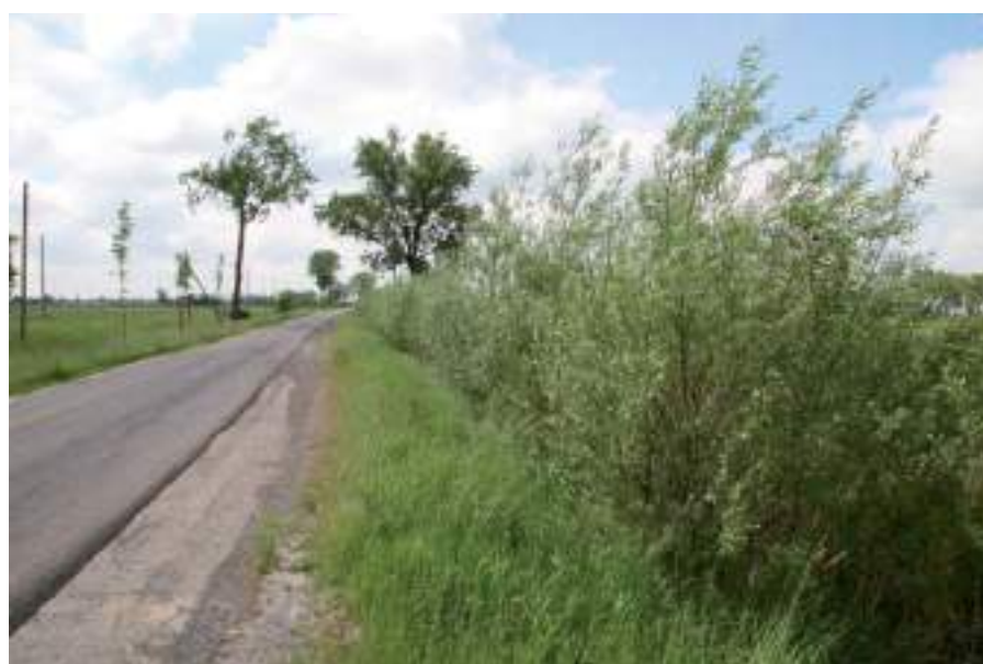
Figura 7 – Fossa dei morti – In alto a sinistra: lavori appena terminati. In alto a destra: stato attuale post-lavori (2009), in cui si nota la crescita di un filare arbustivo di salici bianchi e rossi. In basso: stato attuale post-lavori (2009) con vista del filare arbustivo dalla strada (Foto Marco Monaci).
