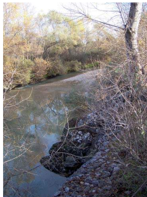
Figura 3.3 – Tratto di fiume Sangro in cui si prevede la rimozione delle difese spondali. Nell'immagine è visibile una difesa spondale realizzata circa 20 anni fa, già in parte scalzata dal corso d'acqua.
