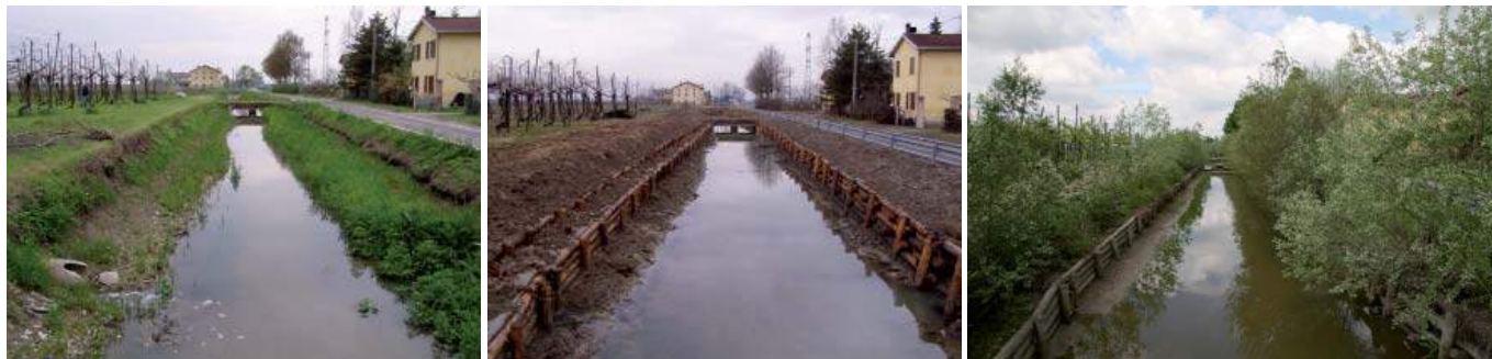
Figura 2 - Canale di Budrione: prima dei lavori (2004), a lavori appena ultimati e a distanza di 5 anni (2009) (Foto: Marco Monaci).
