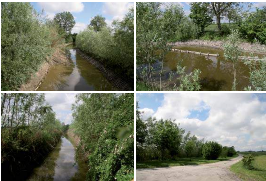
Figura 9 – Cavo Migliarina – Stato del canale dopo la realizzazione degli interventi (2009), con riferimento agli stessi siti mostrati in Figura 8 (Foto Marco Monaci).
