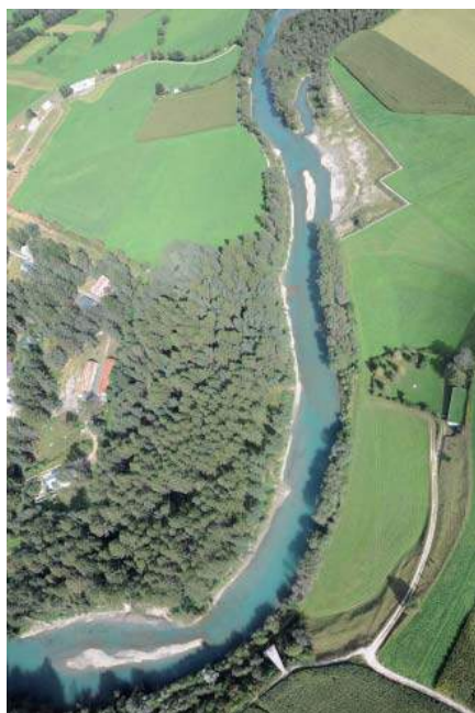
Figura 7 - Allargamento di San Giorgio nel 2008 a lavori conclusi.
