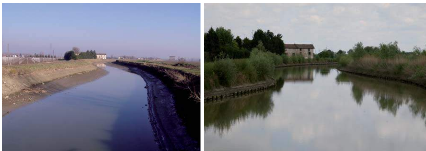
Figura 5 – Cavo Lama. A sinistra: situazione pre-lavori (2004). A destra: situazione dopo la realizzazione degli interventi (2009), nella quale si nota il filare arbustivo-arboreo parzialmente sviluppato (Foto: Marco Monaci).
