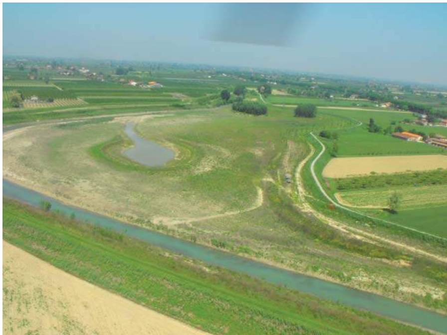
Figura 4 - Veduta dell'area di San Tomè sul Fiume Montone a fine lavori: la gola è stata abbassata e messa in contatto con il fiume, che scorre nella parte sinistra della foto.
