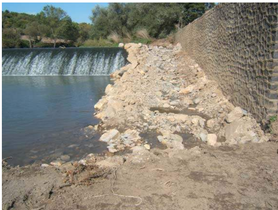
Figura 7 - Rampa in pietra dello sbarramento di Guado della spina.
