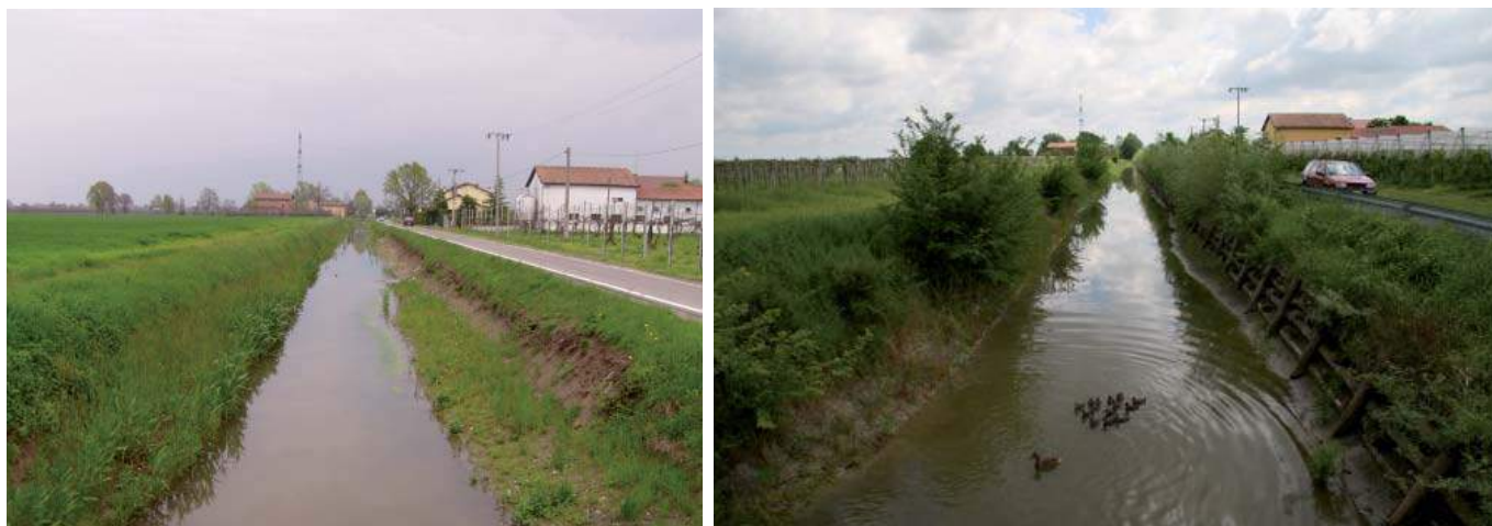
Figura 3 - Canale di Budrione: prima dei lavori (2004) e a distanza di 5 anni (2009) (Foto: Marco Monaci).
