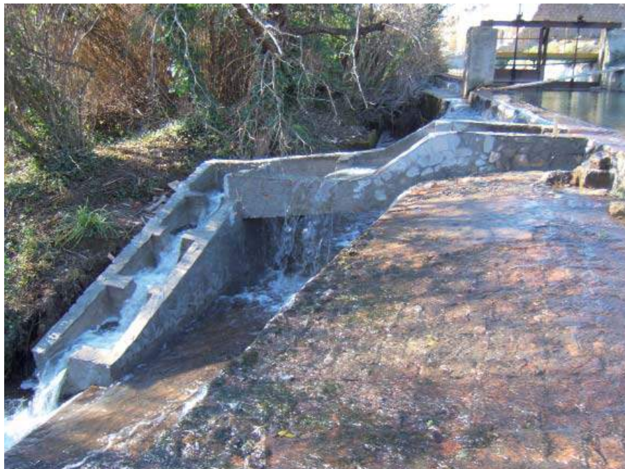
Figura 4: passaggio tecnico realizzato presso la Cartiera di Tuscania.
