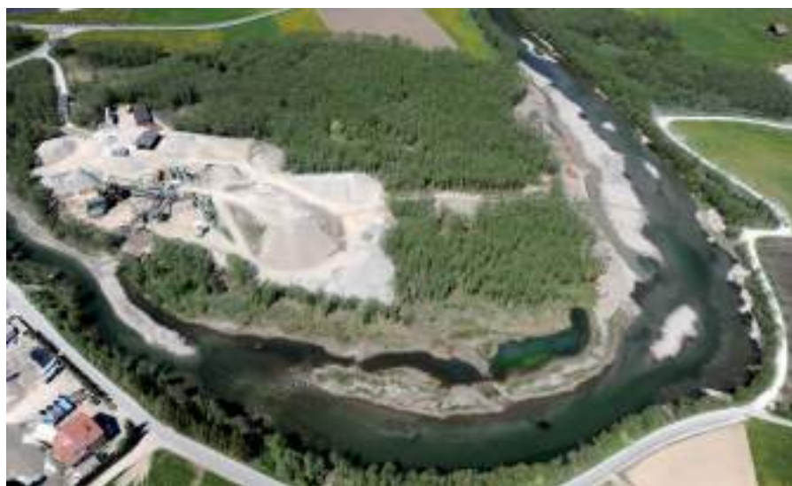
Figura 5 - Gatzau nel 2009 (fasi conclusive dei lavori del II lotto).
