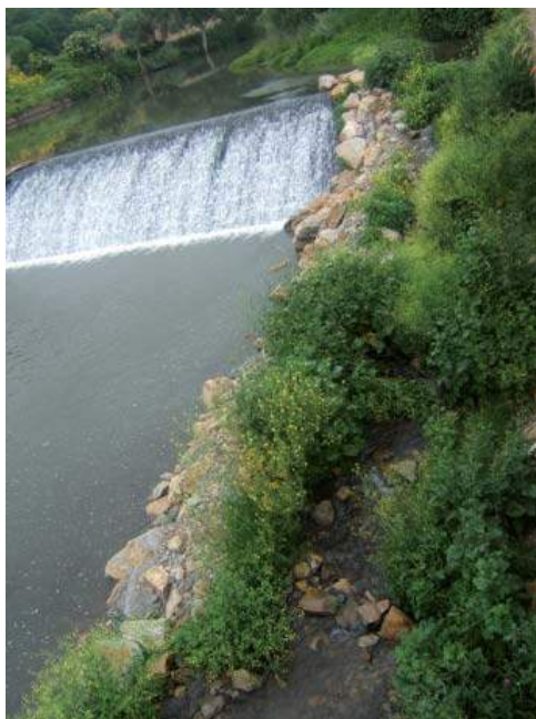
Figura 8 - Rampa in pietra dello sbarramento di Guado della spina, dopo tre mesi dalla realizzazione. Figura 9 - Passaggio tecnico di San Savino 1 intasato dai detriti.
