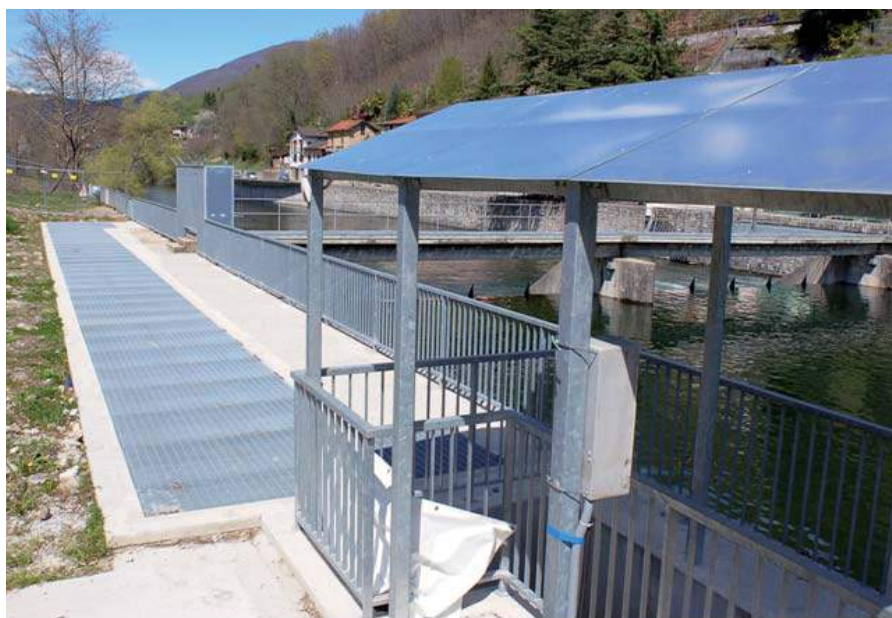
Figura 5 - Il passaggio artificiale per pesci ultimato con in primo piano la scala di accesso alla camera sotterranea di monitoraggio.
