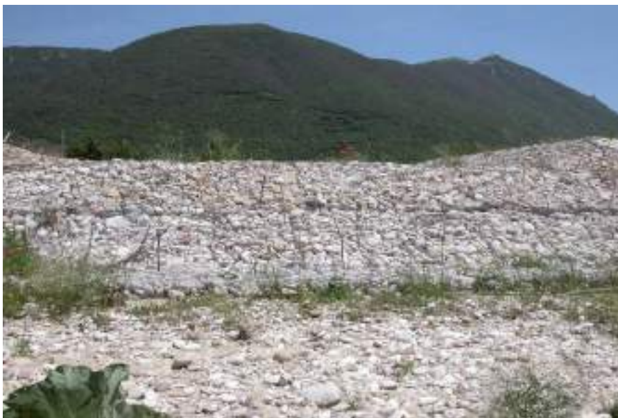
Figura 11 - Inlet realizzato. Totale assenza della vegetazione prevista e talee morte.
