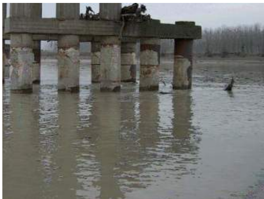
Figura 1 - Esempio di approfondimento delle quote di fondo dell'alveo nel fiume Po e conseguente scalzamento delle fondazioni dei ponti (Foto: Autorità di bacino del fiume Po).
