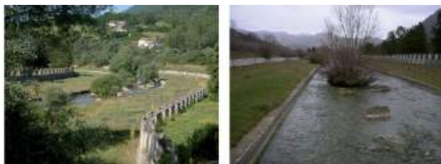
Figura 2.6 – Porzione del tratto canalizzato compreso tra gli abitati di Villa Scontrone e Castel di Sangro.
