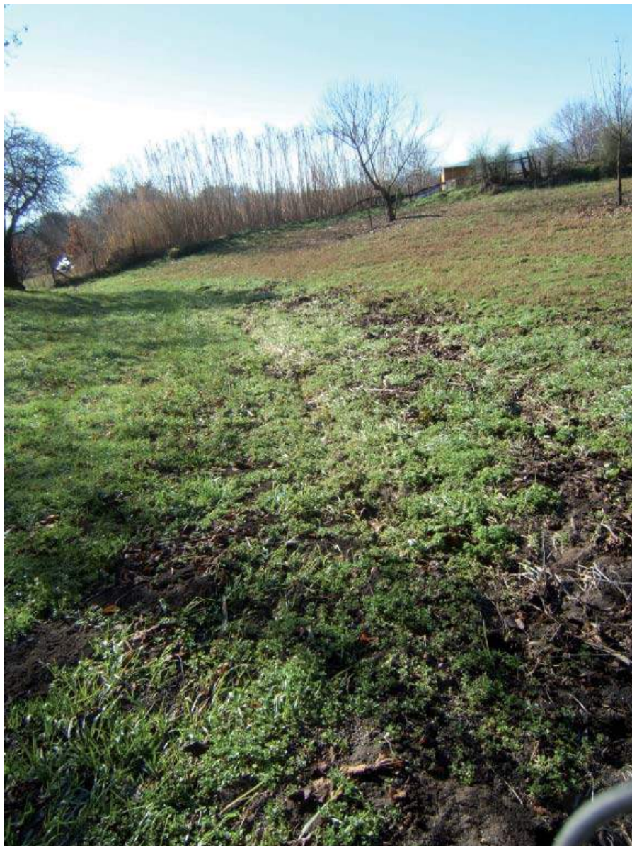
Figura 11 - Alveo del Fosso Scardenato completamente riempito di terreno agricolo.
