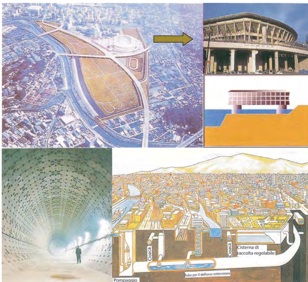
Fig. 2.47. Sopra: realizzazione di edifici “su palafitte” (nello specifico, uno stadio) in zona di esondazione fluviale. Sotto: opere colossali ... già realizzate in Giappone (scolmatori di piena sotterranei ed enormi bacini sotterranei di ritenzione delle acque meteoriche urbane). (Fonte: III World Water Forum, Kyoto, 2003 )
