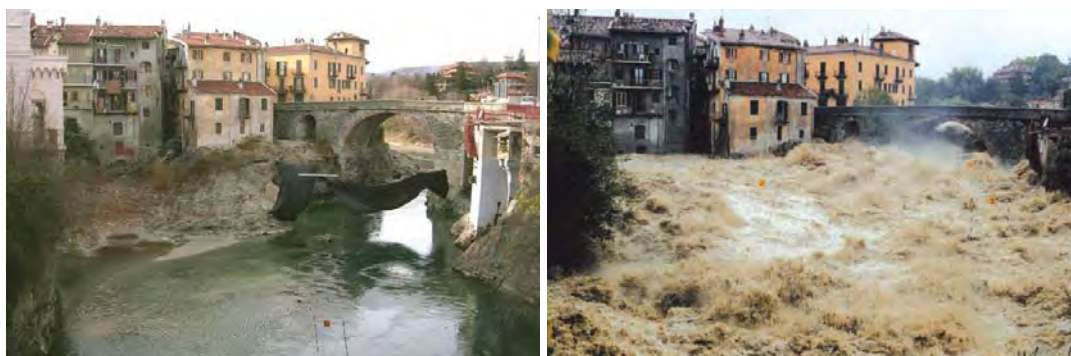
Fig. 2.5. Un ponte esageratamente alto? No, chi l’ha realizzato (forse dopo qualche errore?) sapeva cosa faceva: infatti l’aspetto rassicurante della Dora Baltea al Ponte Vecchio di Ivrea (TO), nelle condizioni abituali (a sinistra), non deve farci dimenticare l’irruenza che è capace di sviluppare in piena (a destra quella del 15 ottobre 2000). (Foto a sinistra: A. Nicola; a destra da MERCALLI, 2001, in NIMBUS)
