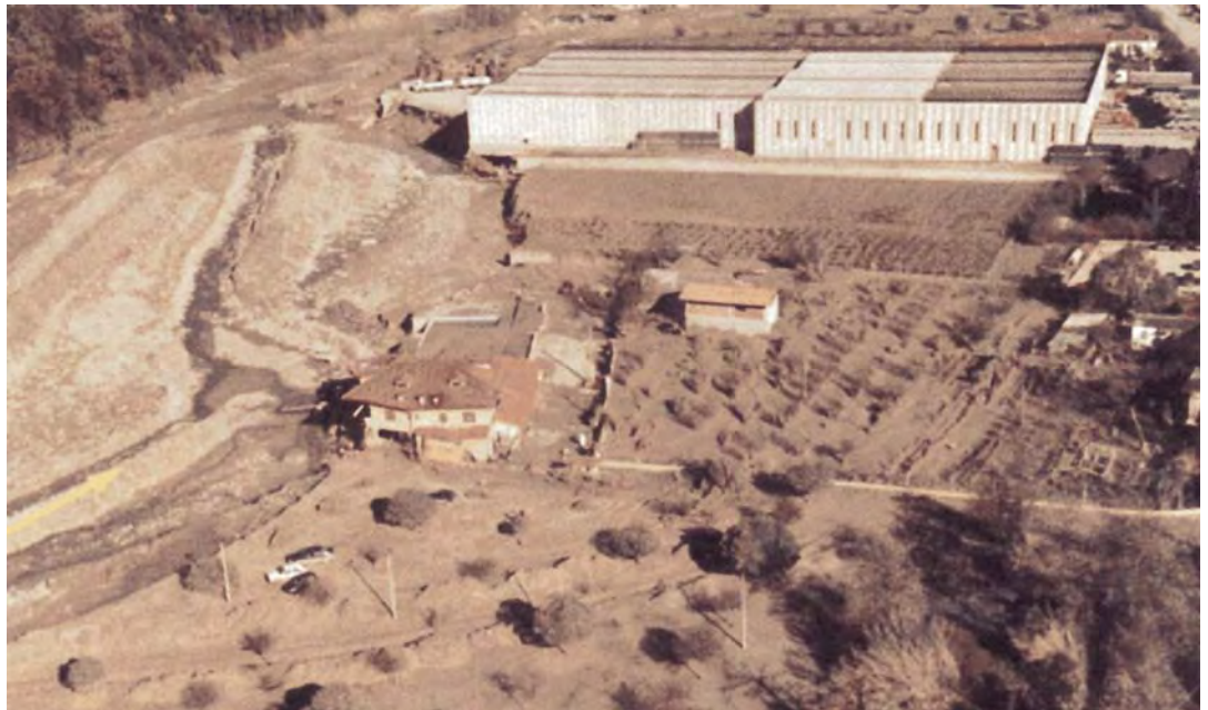
Fig. 2.3. Irresponsabili insediamenti nell'alveo del T. Belbo a Cossano Belbo (CN), danneggiati dalla piena del 5 novembre 1994: uno stabilimento industriale (sullo sfondo) e (a sinistra, lambita dalle acque) una discoteca con piscina e parcheggio (fino agli anni '80 era solo una baracca per pesca sportiva). (LUINO, 2001, in NIMBUS)
