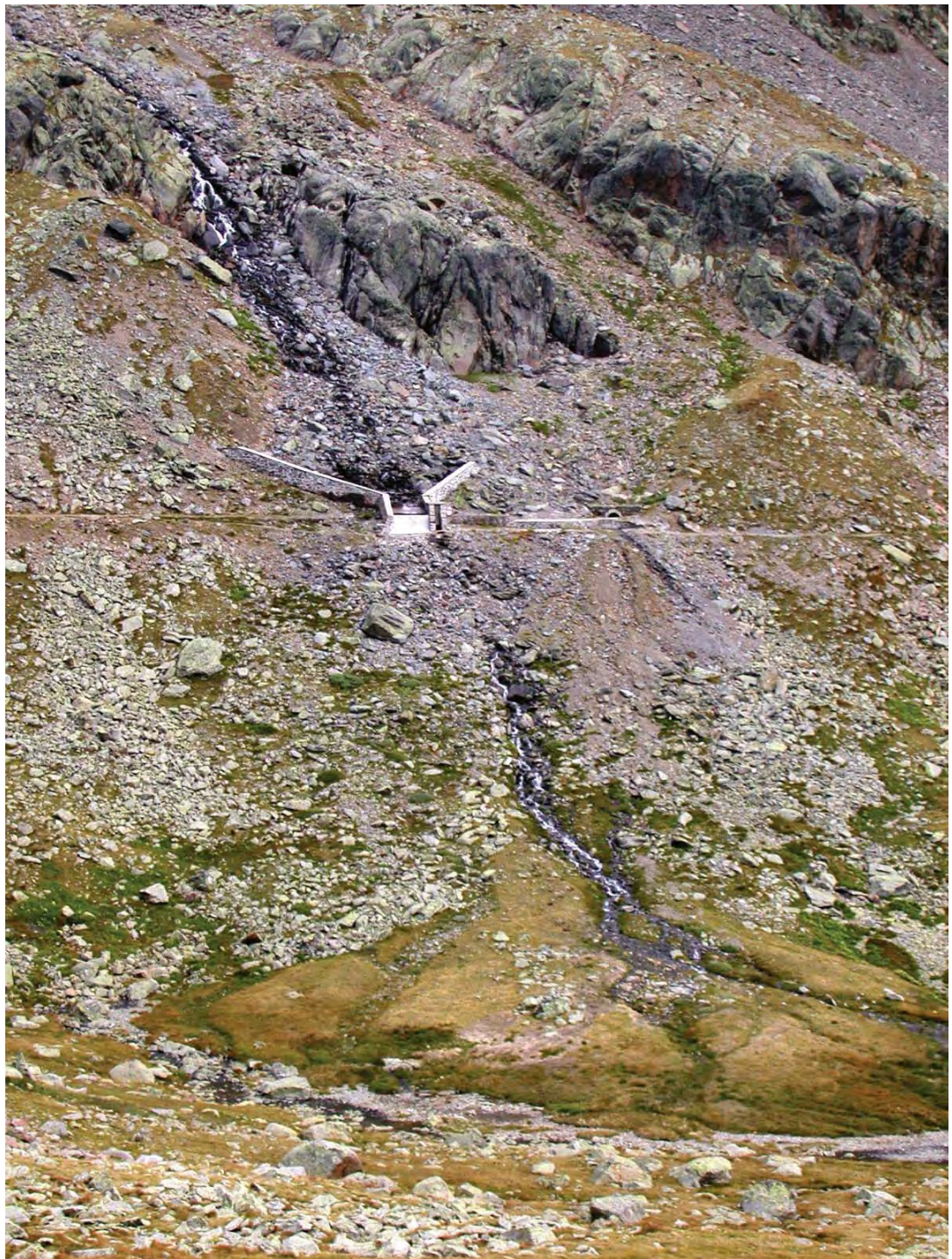
Fig. 5.2. Captazione mediante canale di gronda in alta quota (Val Venezia, Trentino, 2600 m s.l.m.) (Foto: B. Maiolini)
