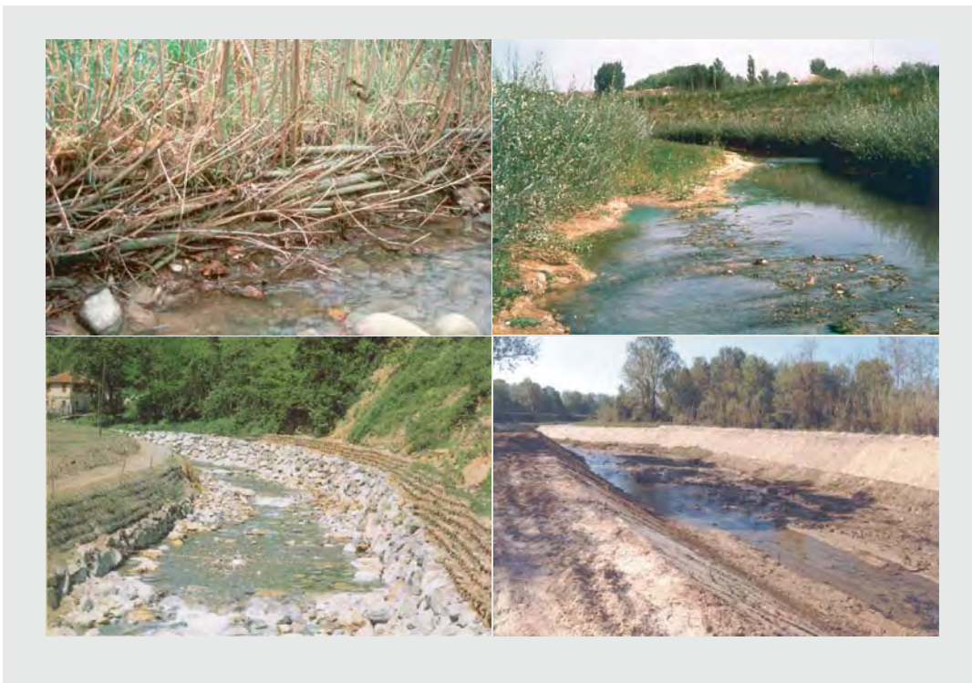
Fig. 1.7. Esempi di ingegneria naturalistica vera (sopra) e falsa (sotto). 1: consolidamento spondale –in zona edificata– mediante viminata viva e georete in fibra di cocco (F. Nesslera a Praroman, Cantone Friburgo, Svizzera, 1987). 2: palificata a parete doppia vegetata a protezione del piede della sponda destra, sulla quale corre l'autostrada (F. Lère a Réalville, Francia, 1997). 3: consolidamento spondale rigido e geometrico: in sinistra idrografica (a destra nella foto) con scogliera; in destra con terra armata, talee e piantine (T. San Martino, prov. GE, 1995). 4: geostuoia preseminata finalizzata a rinverdire e proteggere l'innaturale percorso rettilineo e geometrico (T. Montignoso, prov. MS, 1997). (Foto 1 e 2: B. Lachat, © Biotec; 3: da Regione Liguria, 1996; 4: G. Sansoni)
