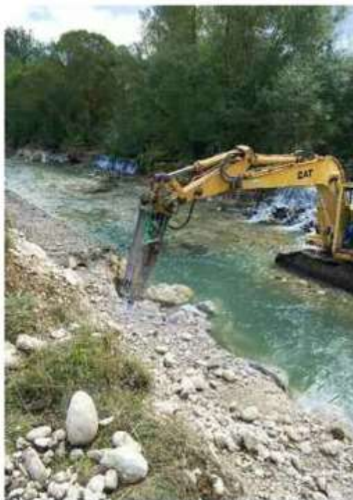
Ruspe in azione per demolire gli argini in cemento
