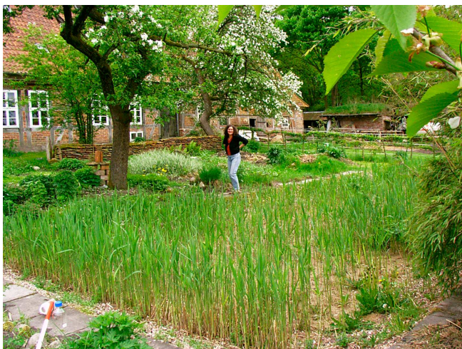
Sistema a flusso sommerso verticale per il trattamento delle acque grigie 10 ae (Neumühlen/Böhme, Lower Saxony; Photo: B. Ebeling)
