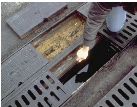
Esempio di filtro a sabbia sotterraneo
