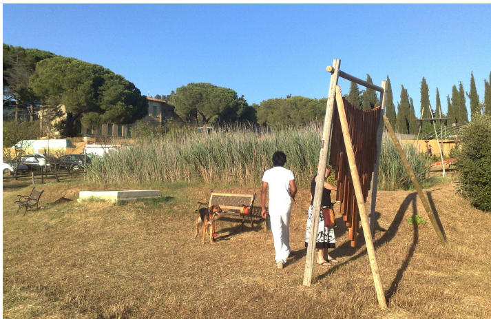
Sistema SFS-h per il trattamento delle acque meteoriche di tetti e piazzali del Centro per l'educazione ambientale di Rispecchia (GR)
