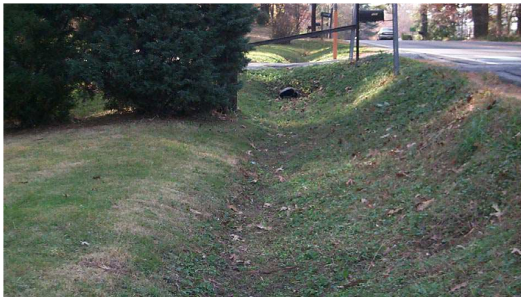
Esempio di canale inerbito
