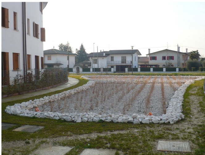
Sistema a flusso sommerso orizzontale SFS-h per il trattamento delle acque grigie (Comune di Preganziol (Tv), 240 ae)
