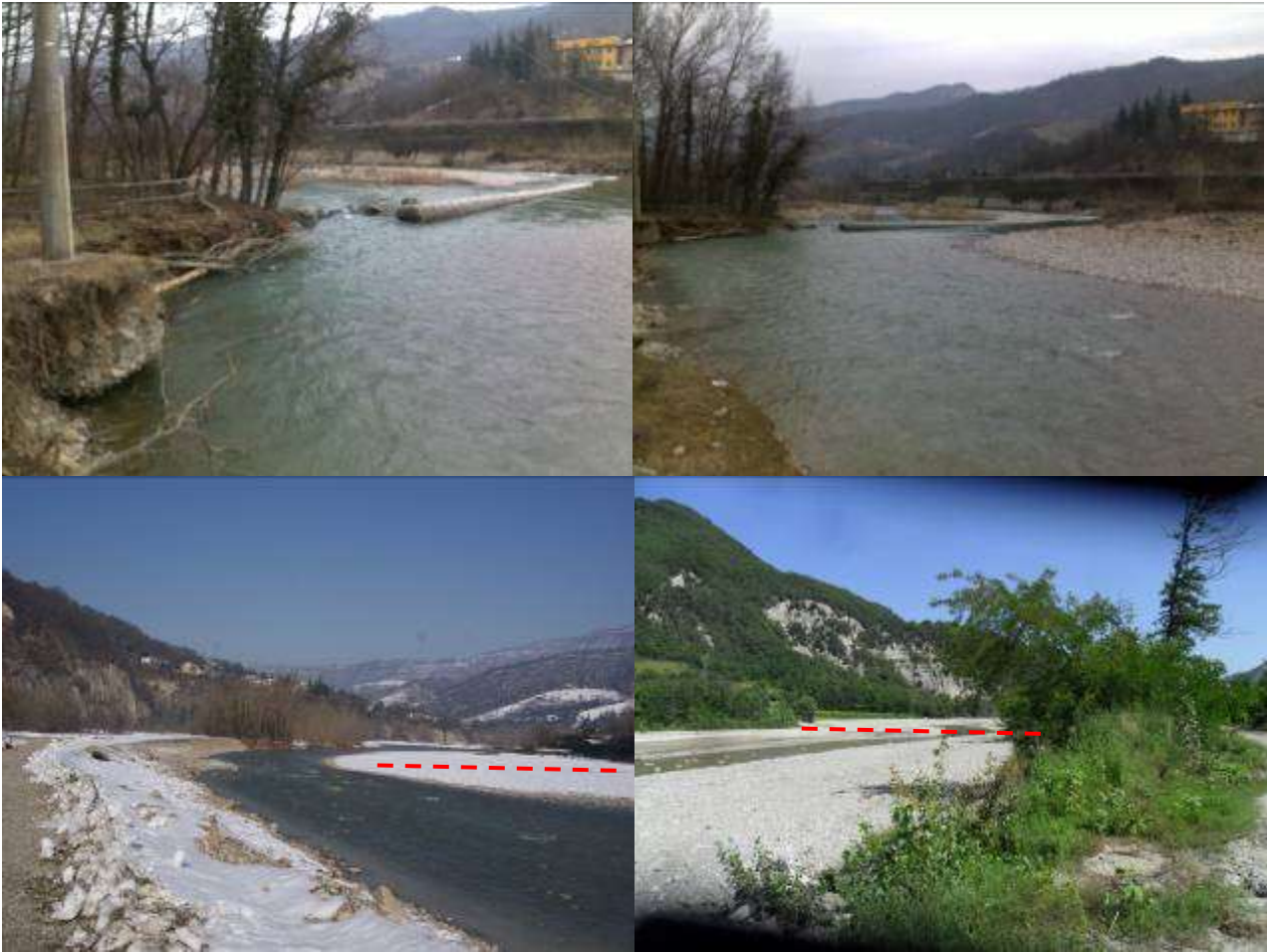
Figura 31 – Rimozione della briglia di Lorianò sul torrente Setta (comuni di Marzabotto e Monzuno, provincia di Bologna).
