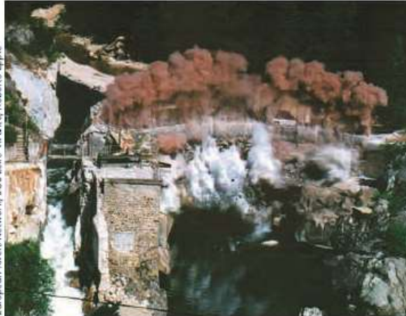
La démolition du barrage de Saint-Étienne-du-Vigan à la dynamite en 1998. Le cours d'eau est détourné en rive droite.
