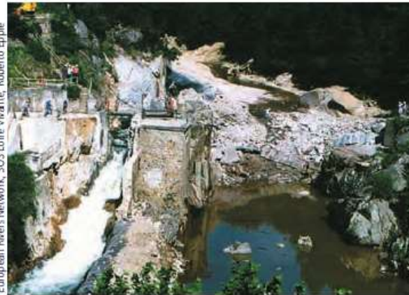
La démolition du barrage de Saint-Étienne-du-Vigan à la dynamite en 1998. Le cours d'eau est détourné en rive droite.
