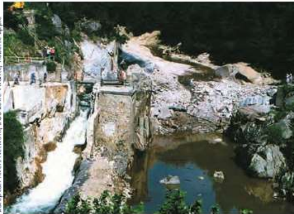
La démolition du barrage de Saint-Étienne-du-Vigan à la dynamite en 1998. Le cours d'eau est détourné en rive droite.
