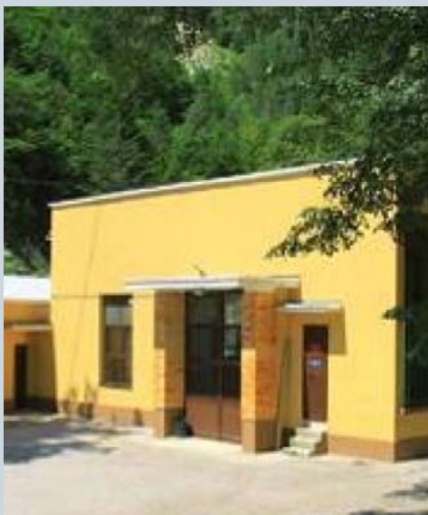
Powerhouse of HPP Možnica
