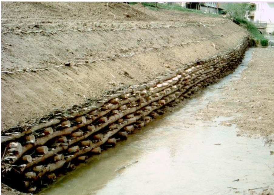
Foto 3 – La sponda sistemata, subito dopo la conclusione dei lavori, in basso la palificata doppia viva sovrastata da due ordini di gradonata, realizzata sempre con talle di salicacee. Tra i due ordini della gradonata sono stati posti in opera arbusti di ginestra, rosa canina, viburno e sanguinello.
