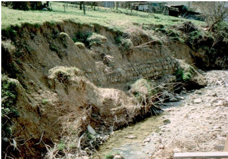
Foto 1 – Situazione della sponda prima degli interventi.
