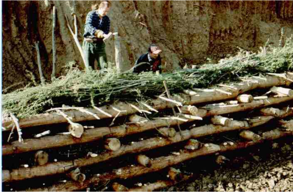
Foto 2 – Palificata doppia durante le fasi della sua realizzazione, si noti le talee (astoni) di salice posizionati, correttamente, durante la realizzazione della palificata.
