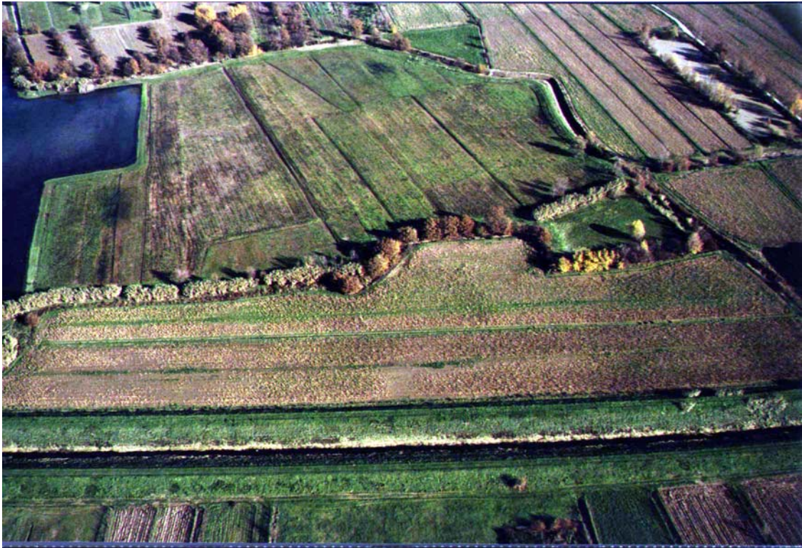
Foto 1 – Vista area dell'aerea della "Laghina" prima degli interventi per la realizzazione dell'area umida.
