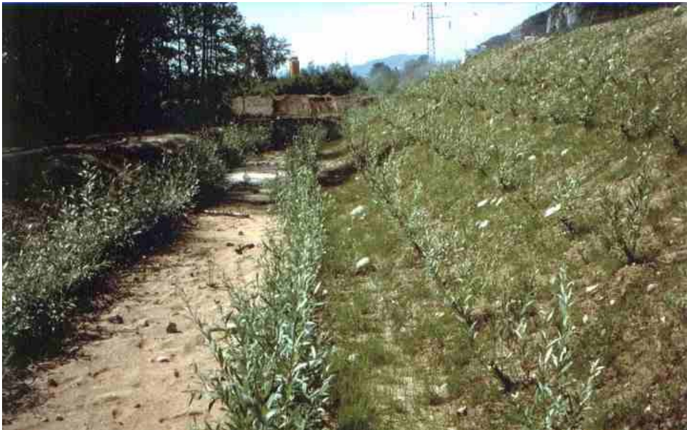
Foto 5 – Particolare dello stesso argine tre mesi dopo la realizzazione dei lavori di rinverdimento e consolidamento con inerbimento protetto con georete in juta e picchetti di salice. A sinistra si noti il fossetto realizzato a scopo faunistico.
