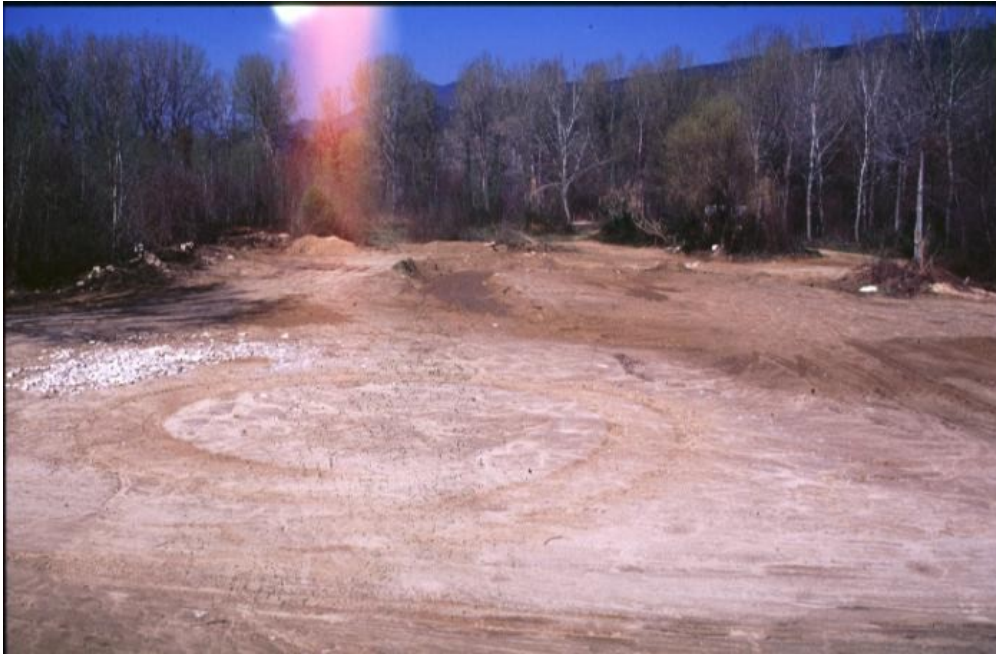
Foto 1: Area dove è stato realizzato uno degli stagni previsti in progetto. Lo stagno ha uno scopo sia naturalistico che tecnico – funzionale, dovendo funzionare da sistema filtro per le acque dei canali in entrata nel Lago di Porta.
