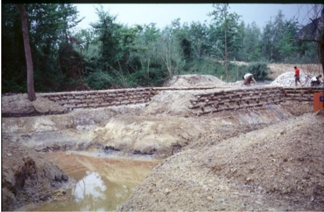
Foto 2 – Fase di realizzazione dello stagno - filtro, un lato è stato completamente realizzato in palificata doppia rinverdita per permettere la collazione di una pompa per l'allontanamento dei sedimenti depositati.
